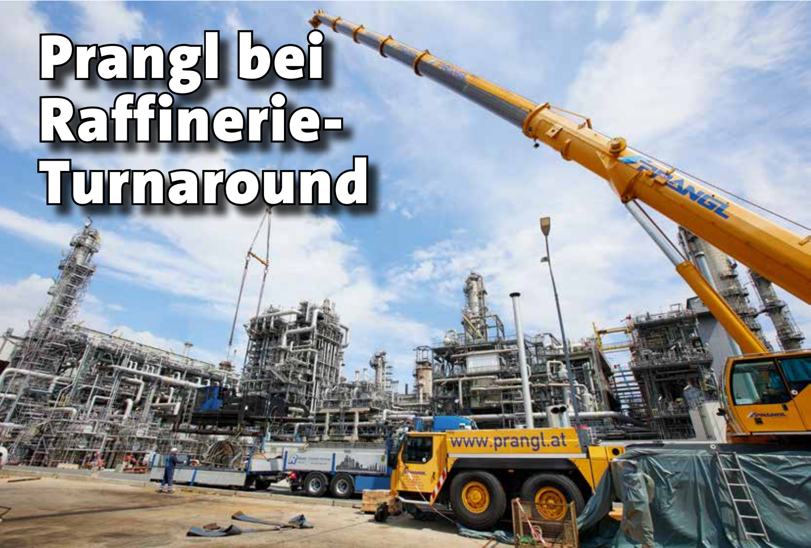
Mobilkrane von Prangl beim Einsatz in der OMV-Raffinerie in Schwechat.
