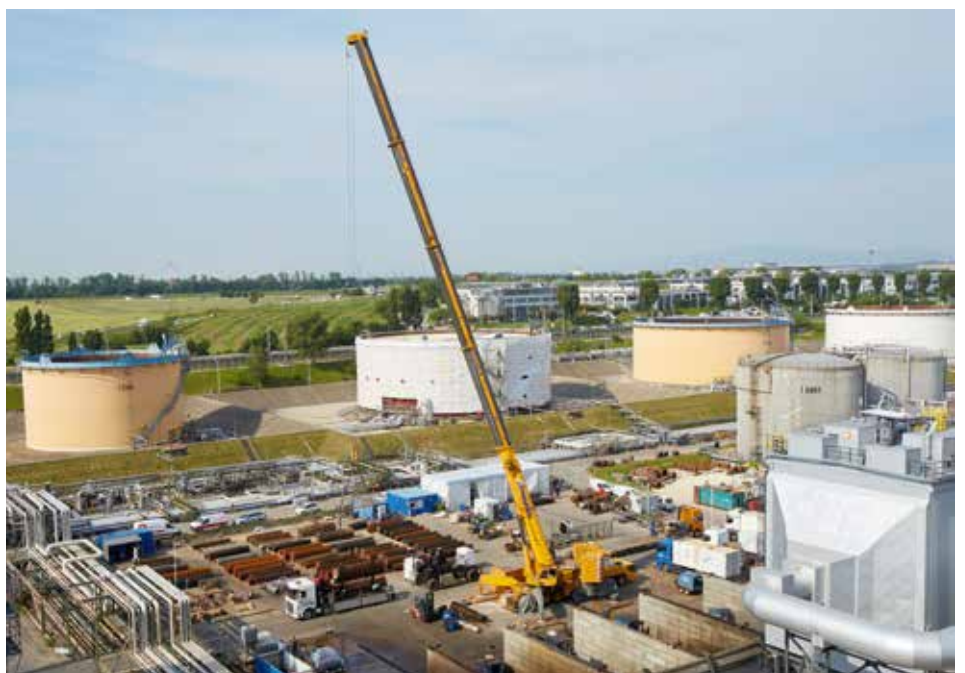
Prangl-Mobilkran hebt Raffinerie-Element auf LKW.
