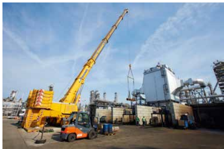
Viele Einzelteile müssen ausgehoben transportiert werden.
