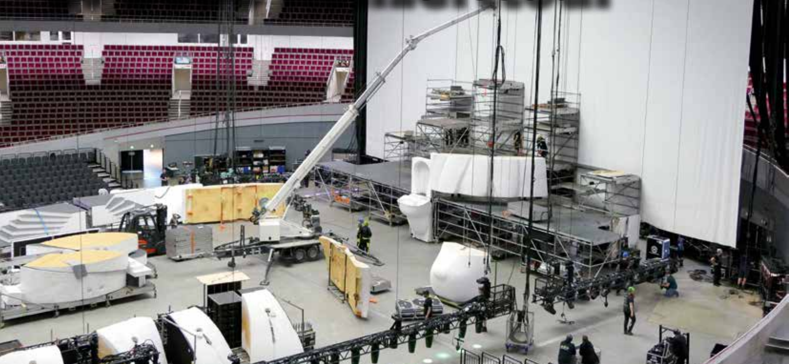
Die zehn Einzelteile der Bühne hob der Böcker-Kran in zwei Stunden.
