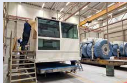
Abkleben der Kranführerkabine.
