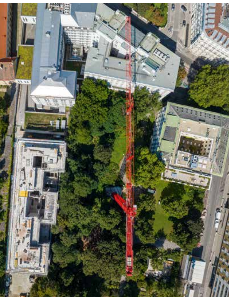
Der WOLFF 8060.25 Cross, zurzeit der stärkste Baukran Österreichs. 7,0 Tonnen Spitzentragfähigkeit bei 80 Meter langem Ausleger.
