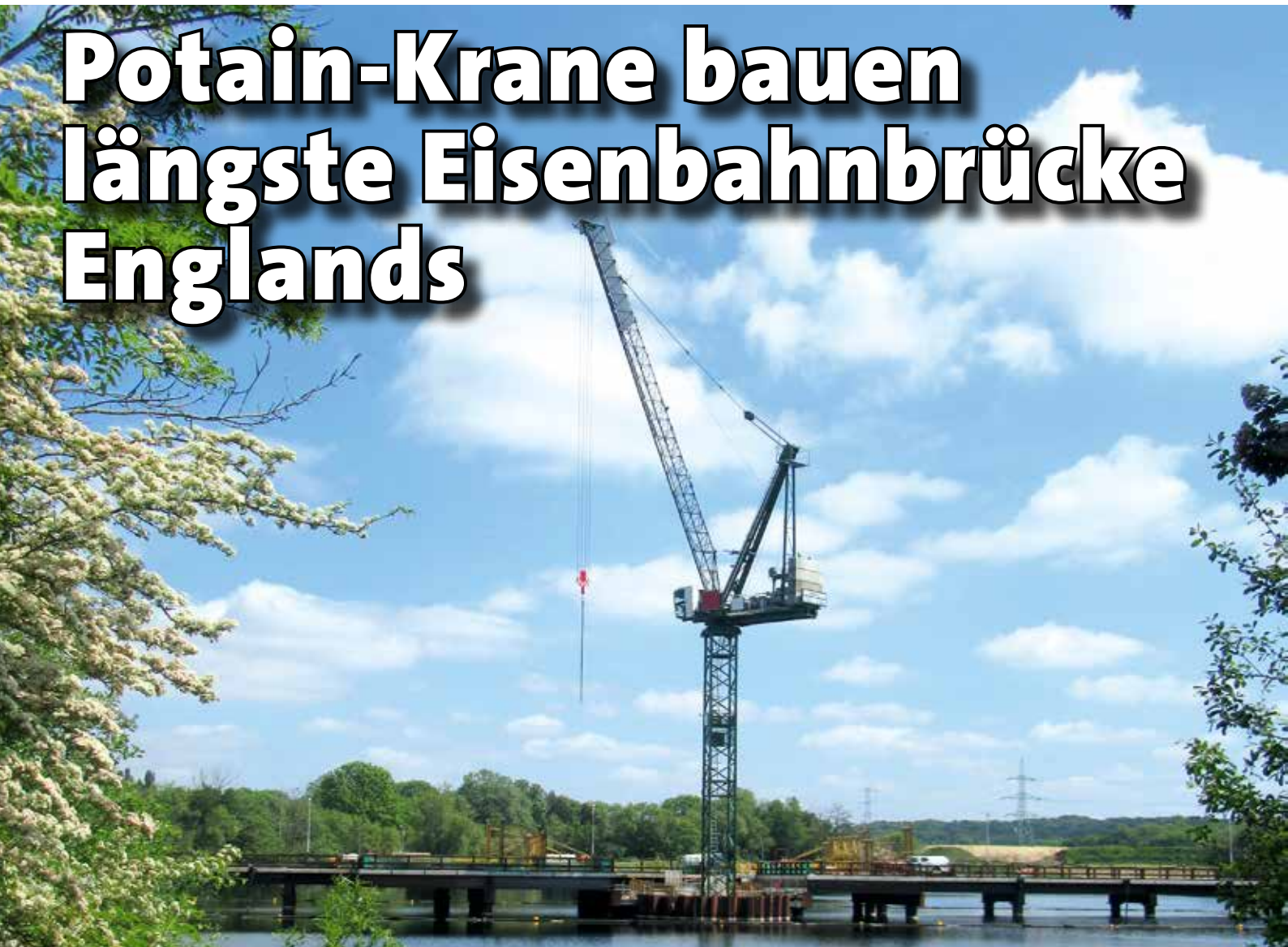
Potain Wippauslegerkrane beim Bau der längsten Eisenbahnbrücke Englands.
