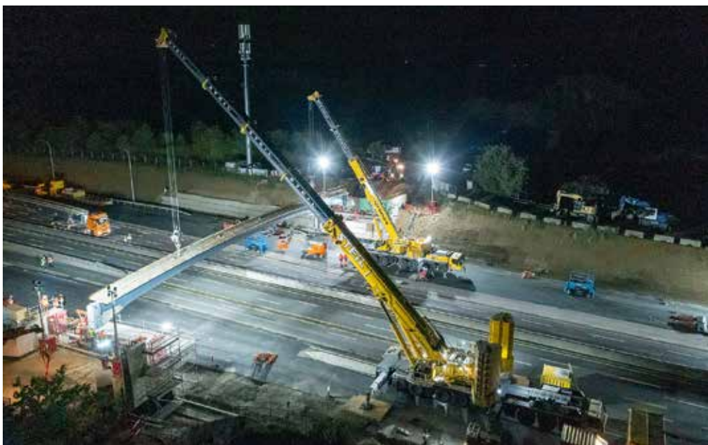
Klassischer Tandemhub: Steil/ATS-Krane setzen die riesigen Träger auf den Widerlagern ab.
