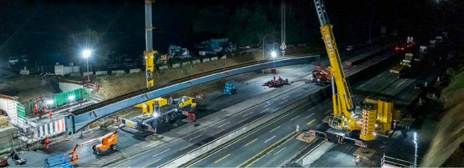
Kranduo Liebherr LTM-1300-6.3 und Liebherr LTM1650.8.1 beim Abheben der 92 Tonnen schweren mittleren Brückenträger auf der A3 bei Berchem/Luxemburg.
