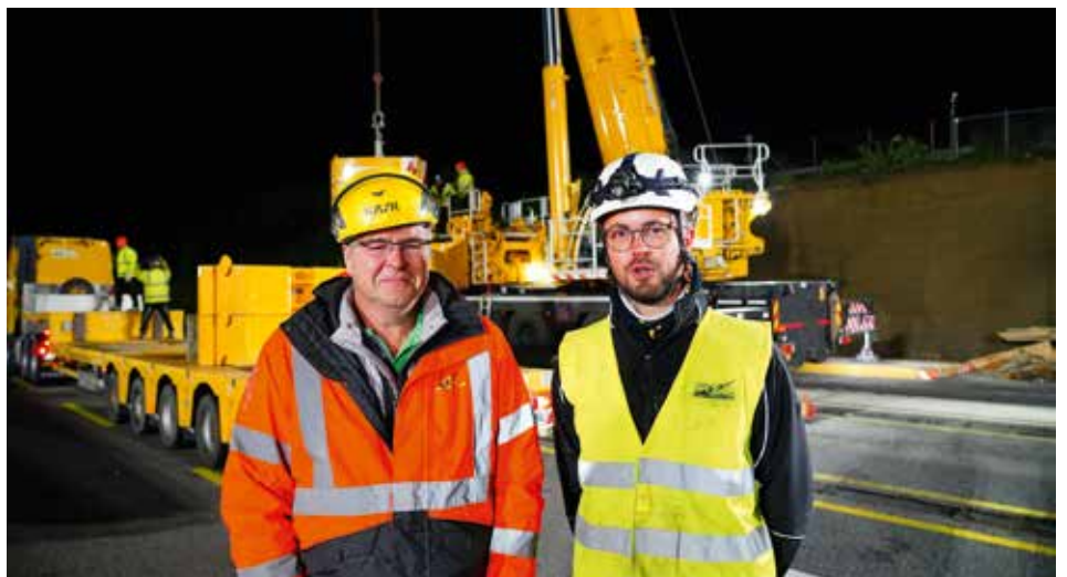
Frederic Kleinhans (links) hat den Einsatz in Luxemburg geplant, Christoph Steil aus der Geschäftsleitung war mit dem LTM 1650-8.1 angereist und überwachte die Arbeiten.
