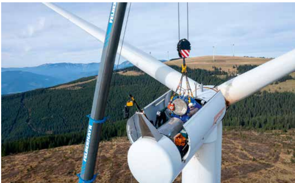
Aus- und Einbau des Getriebes; auch für den Kranfahrer bedeutet das stundenlange Konzentration.
