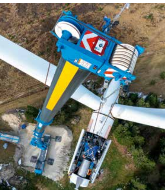
Am Rollenkopf des Krans überträgt eine Kamera das Geschehen aus der geöffneten Gondel direkt in die Fahrerkabine.
