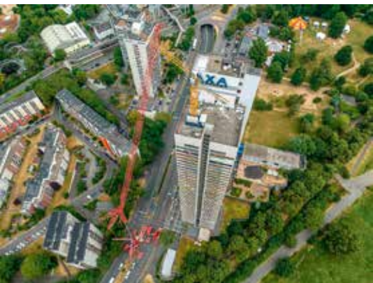
In Einzelteilen wird der Turmdrehkran auf das Dach des Axa-Hochhauses gehoben.
