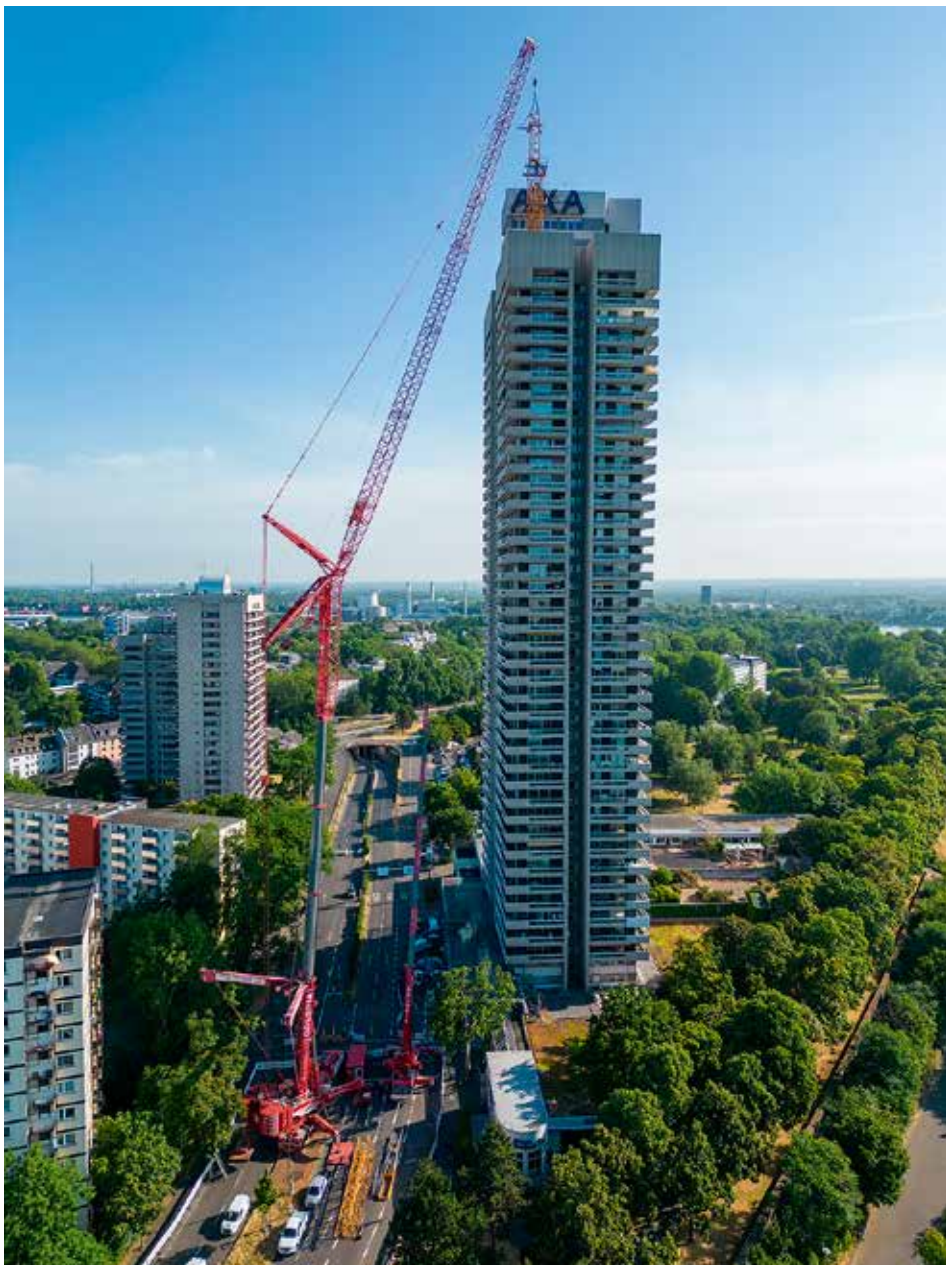
Unterstützt von einem LTM 1150-5.3 installiert ein LTM 1750-9.1 einen Turmdrehkran in 147 Meter Höhe.
