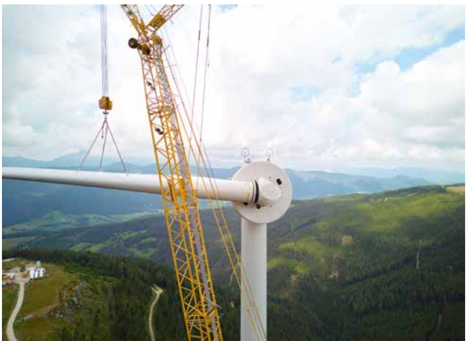
Einhub und Montage des ersten Rotorblatts, Länge: 78,5 m, Gewicht: 21,8 t.
