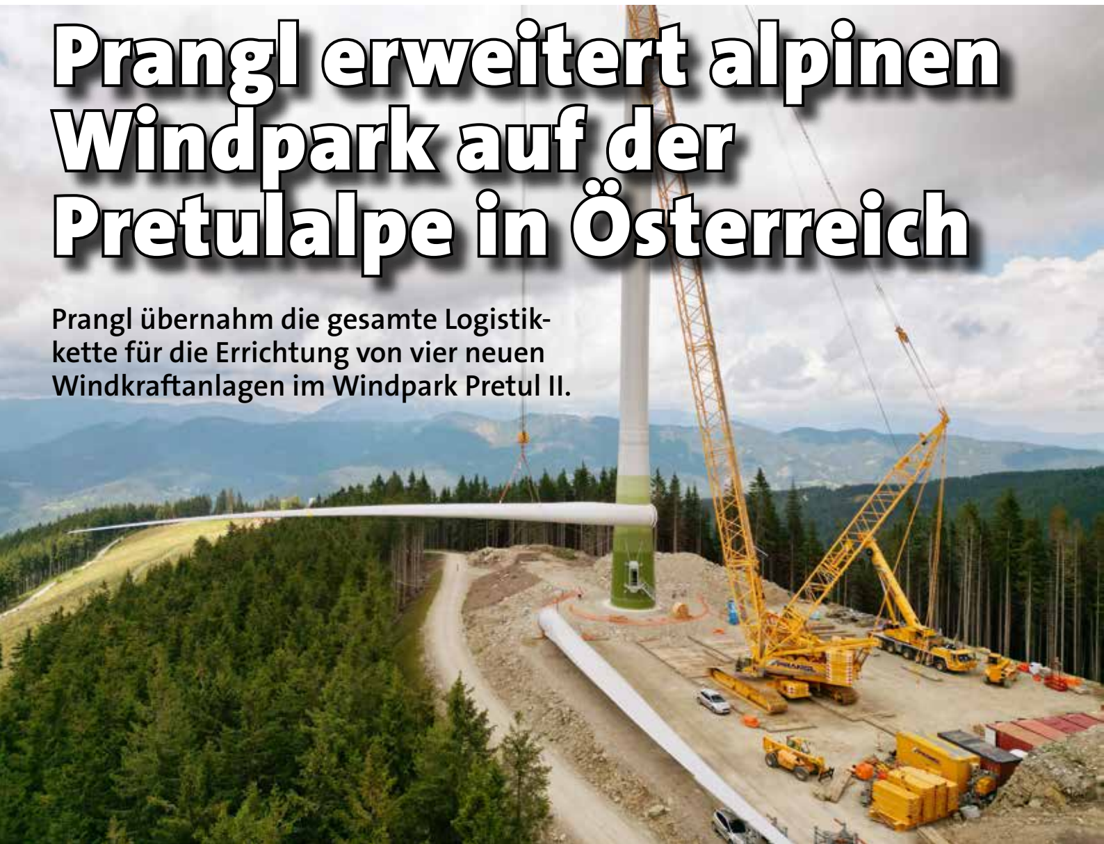
Ein 600 Tonnen Raupenkran hebt die Flügel auf eine Nabenhöhe von 110 Metern.
