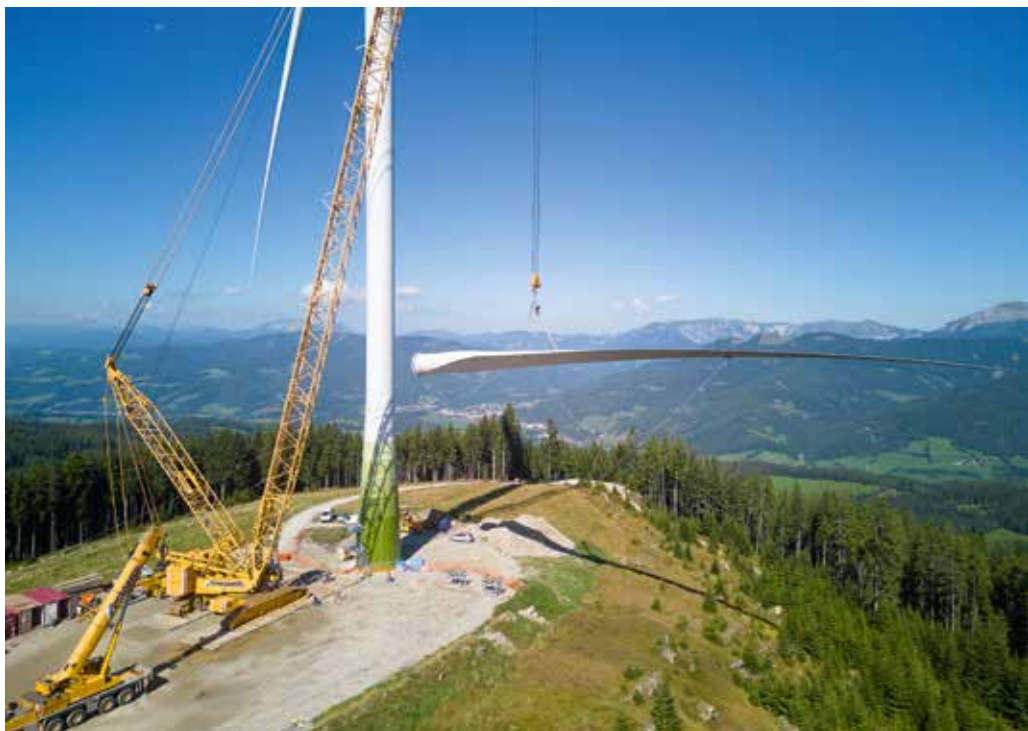
Es folgt die Montage des zweiten Rotorblatts.
