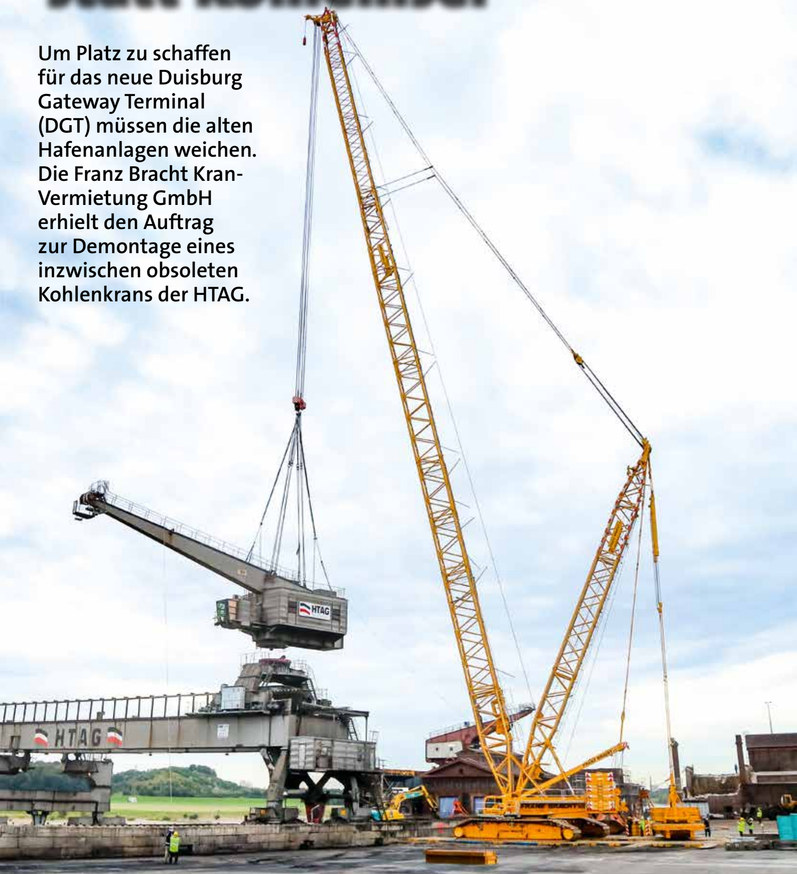
Kran mit Kran am Anschlag.
