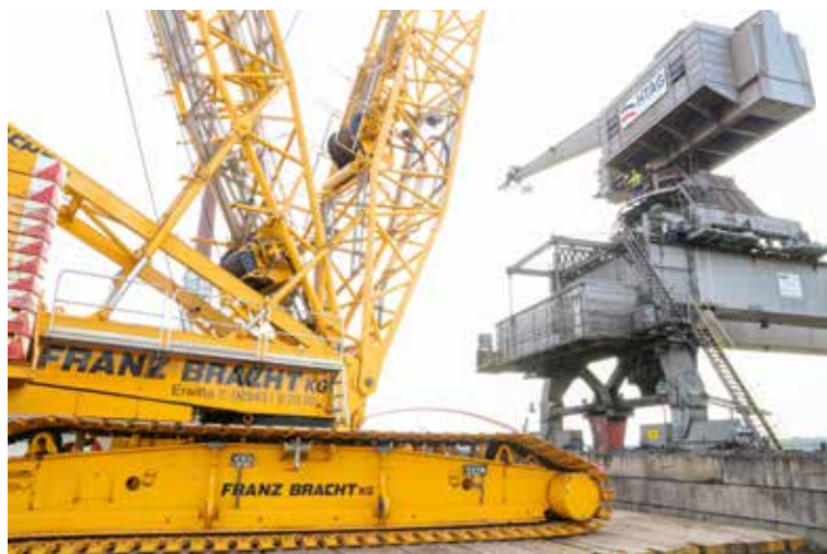
Der alte Kohlekran von HTAG wird demontiert.
