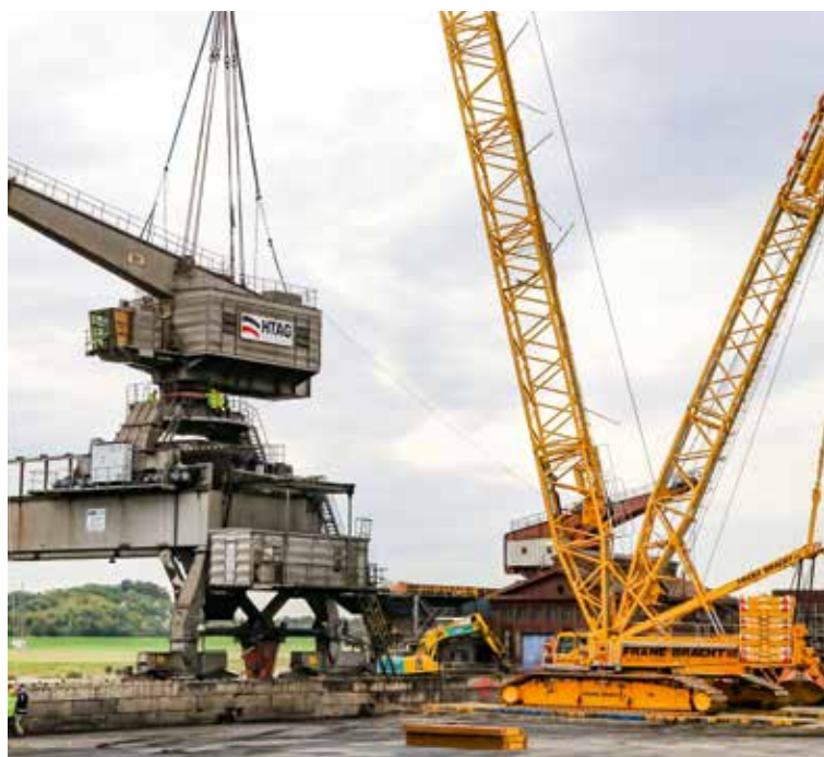
Vorbereiten für das Lösen des Kohlekran-Ausleger von der Drehbühne ...
