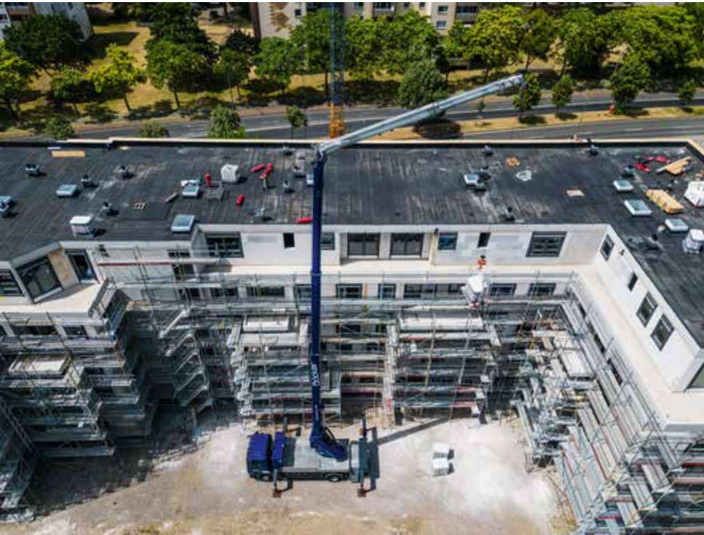
Die senkrechte Maststellung und der geringe Durchschwenkradius ermöglichen das Arbeiten nah an der Fassade.
