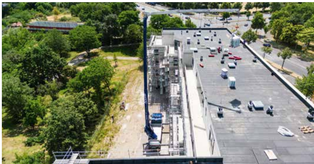
Turmdrehkranfunktion im Einsatz: Bequemes Austeleskopieren der Palette.
