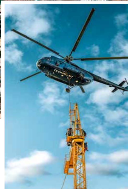
Kranimex-Service-Monteur nahmen die Krankomponenten aus der Luft entgegen.
