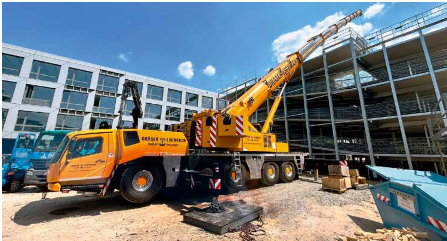
GMK 5250-1 von Gräser-Eschbach bei der Modernisierung des VfB-Stadions.
