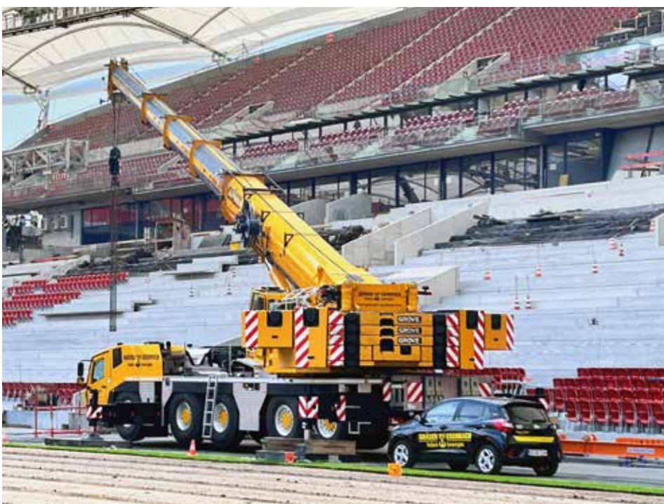
Kapazitätserweiterung mit dem Grove GMK 5250XL-1 im Stuttgarter Fußballstadion.
