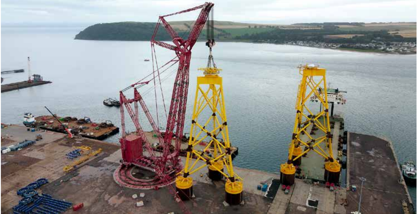
Während die Jackets per SPMTs auf den Kai antransportiert werden, hebt der Ringkran Jackets auf die „Feederbargen“.
