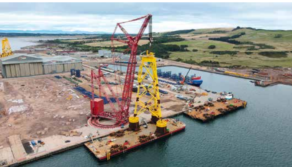
Der Ringkran PTC 210 DS von Mammoet beim Hub eines „Jackets“.
