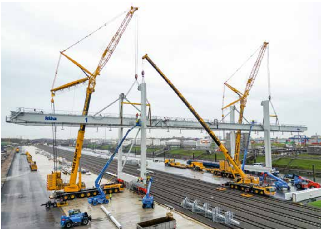
Die vierte Stütze wird von einem LTM 1300 eingehoben.
