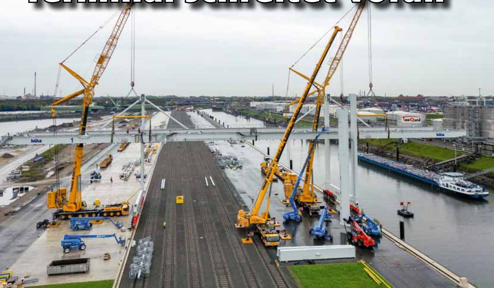
Per Tandemhub sicher eingehoben, der zweite Hauptträger der Containerbrücke im DGT.
