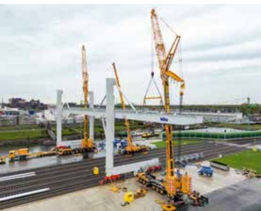
Zwei LTM 1450-8.1 im Einsatz von Franz Bracht im Duisburger Hafen.
