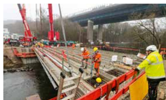
Nach dem Einhub erfolgt die Feinjustierung.
