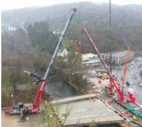
Der 8. Träger wird eingehoben.
