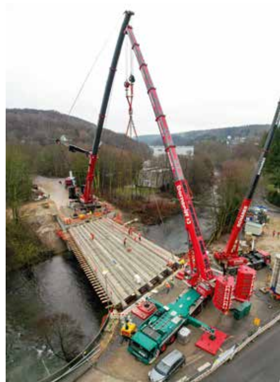
Bereits 6 Träger sind eingehoben.
