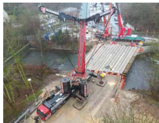
Der LTM 1650-8.1 von Schares in TY3-Konfiguration.
