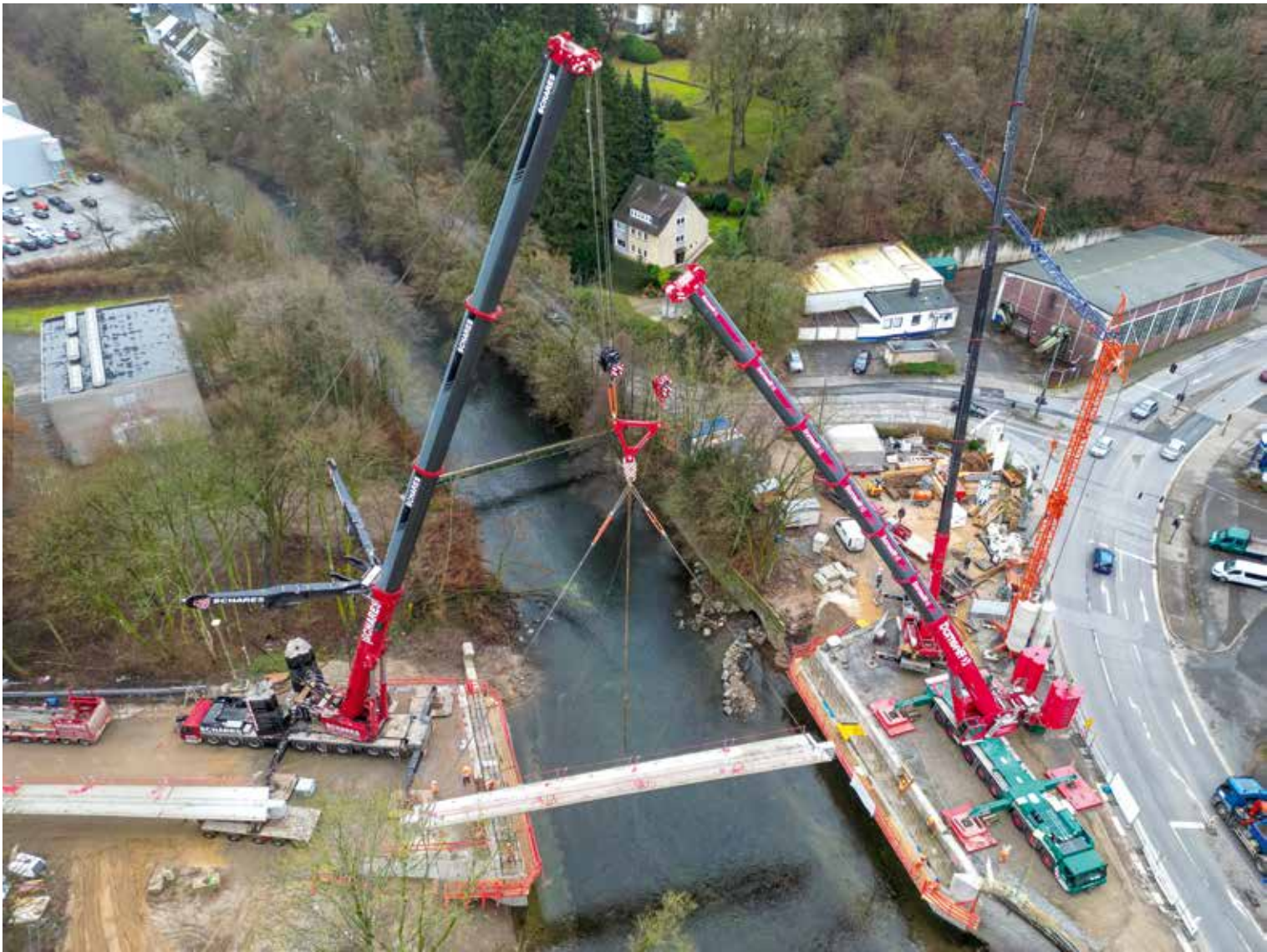
Der erste von acht Stahlbetonträgern wird über der Wupper eingehoben.
