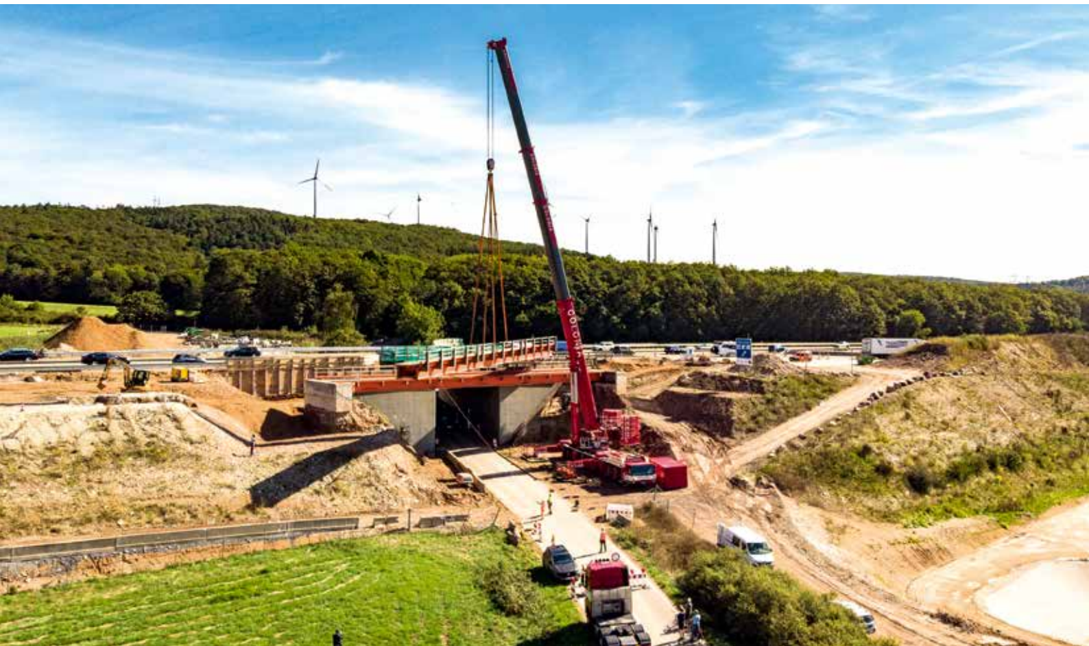
Brückenteil Nr. 1 schwebt.
