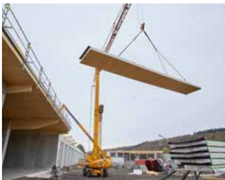
Holzdeckenteile am Haken des Mobilbau-Raupenkran von Prangl.
