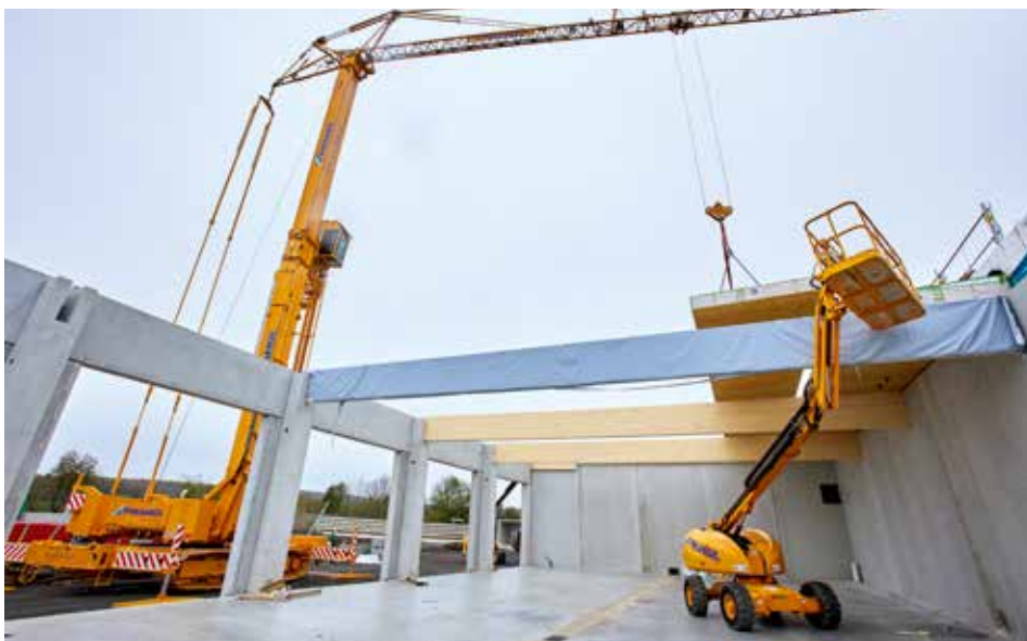
Nach und nach wird das Dach der Straßenmeisterei gedeckt.
