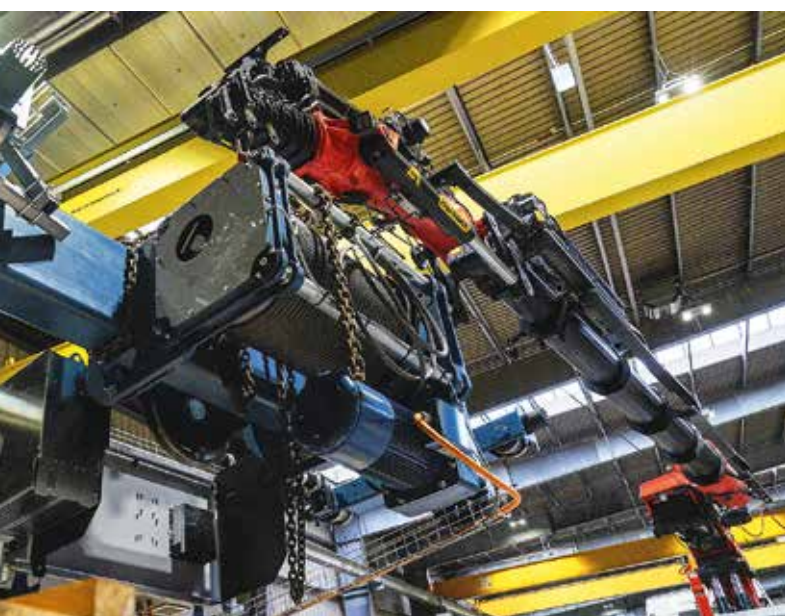
Abbau der Seilwinde des alten Hallenkrans.
