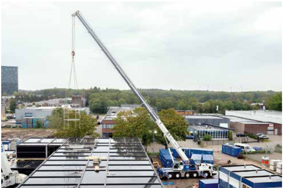
De Meeuw setzt seinen neuen Kran bei einem großen Wohnungsbauprojekt in Nijmegen ein.
