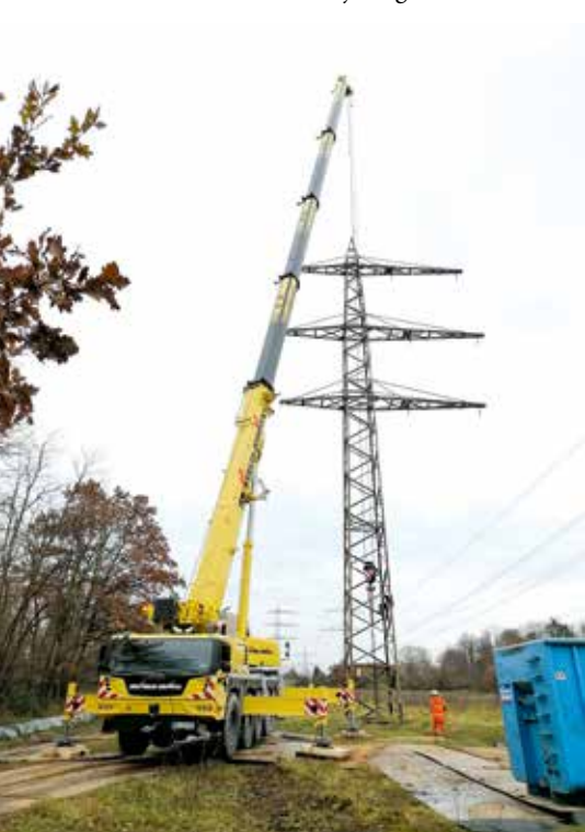
Erster Mobilkran im Fuhrpark: Liebherr LTM 1110-5.2.
