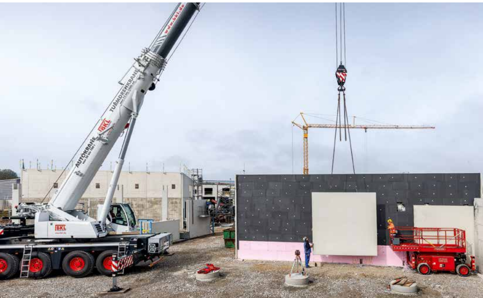
Ballasttransport eingespart: Für die Montage der bis zu 5 Tonnen schweren Elemente waren nur 13,4 Tonnen Gegengewicht erforderlich.
