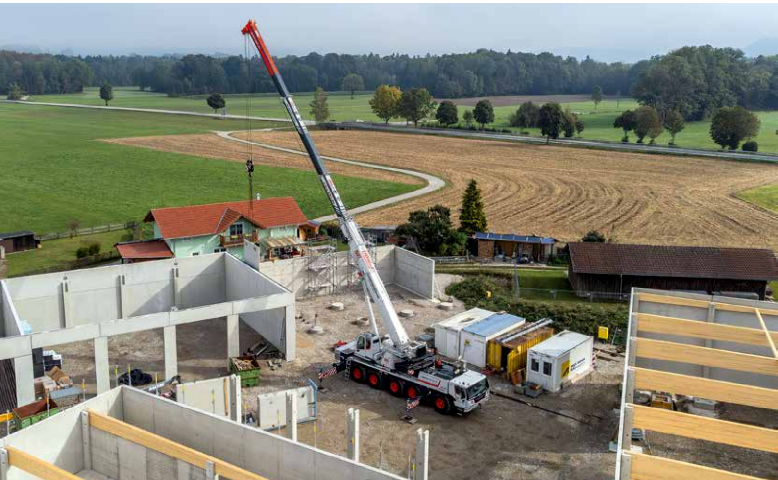
Ersteinsatz: Der LTM 1110-5.2 von BKL montiert feinfühlig Beton-Fertigteile.
