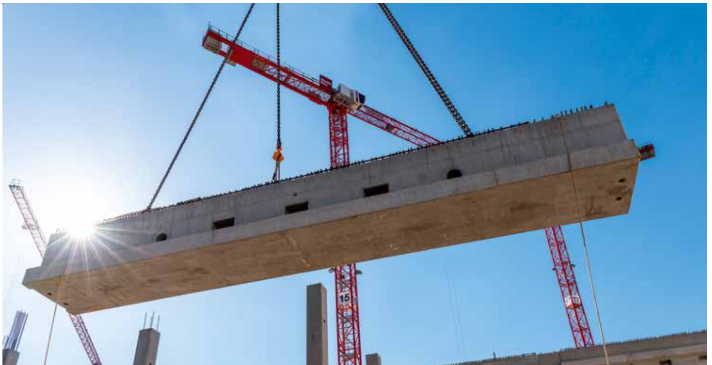
Bis zu 22 Tonnen schwere Betonteile wurden eingehoben.
