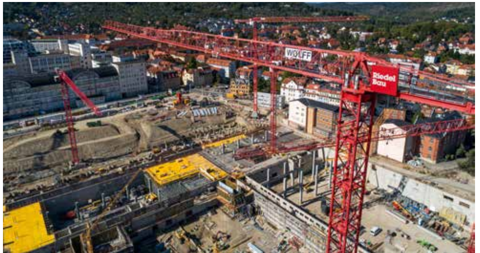
Die Baustelle des neuen Hightech-Standortes von Zeiss in Jena.
