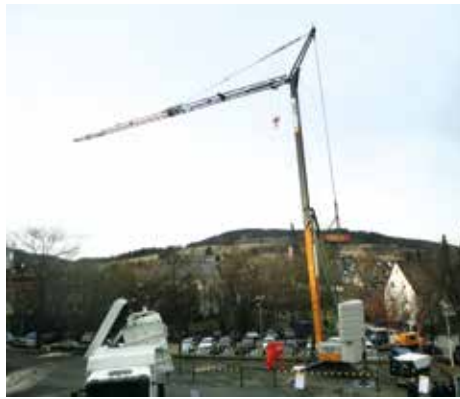
An diesem Schnelleinsatzkran L1.23.1 stellt Liebherr sein neues TDK-Assistenzsystem und die mobile Batterielösung praktisch dar.
