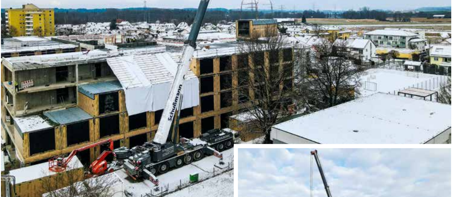
Der LTM 1450-8.1 verheiratet die Holzmodul-Wohneinheiten mit dem Betonkorpus.
