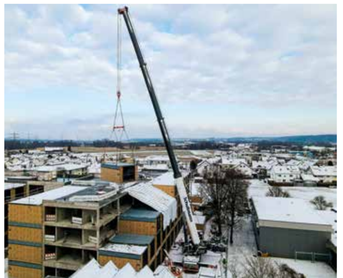
Bei der Montage der letzten der rund 15 Tonnen schweren Module kommt der LTM 1450-8.1 mit lediglich 34 Tonnen Ballast aus.
