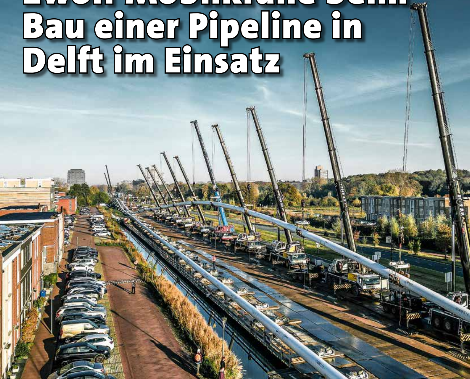
Ein Dutzend Liebherr-Krane im Einsatz bei einem Pipeline-Bau für das Fernwärmenetz in den Niederlanden.
