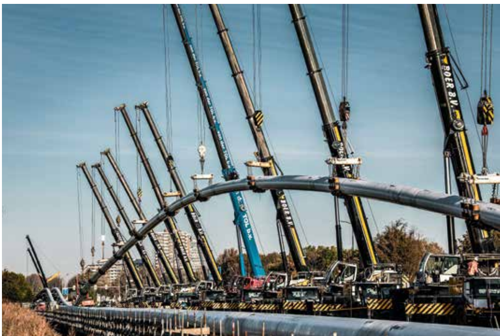
Vor der Bohrung brachten die Krane die Rohrleitung in eine definierte Krümmung.
