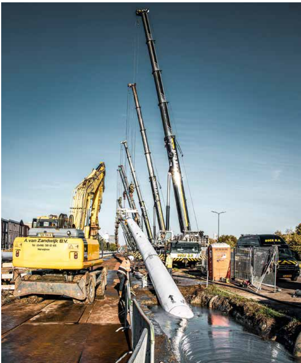
An einem Ende der Fernwärmeleitung wurde ein Bohrkopf installiert.
