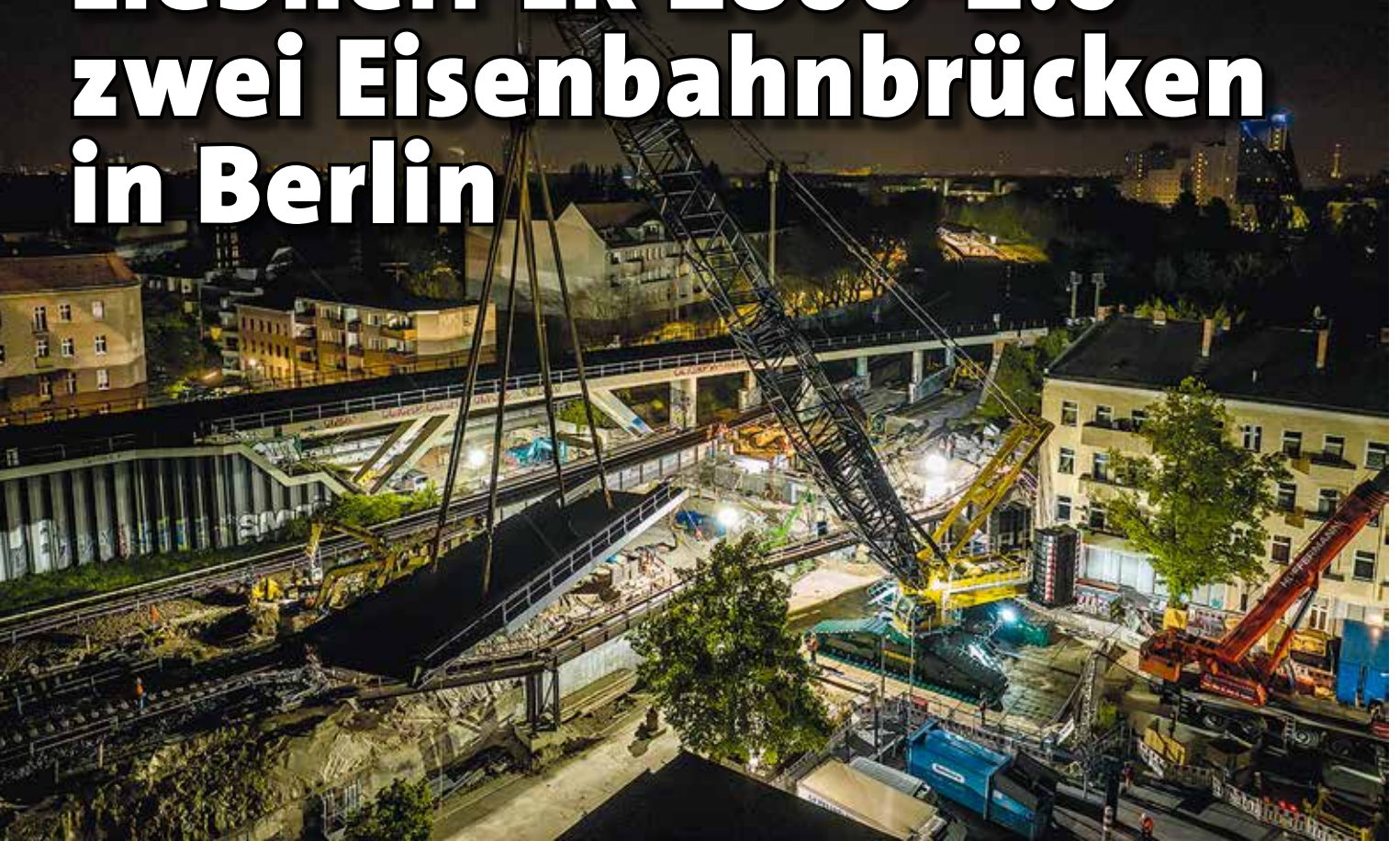
Thömen montiert mit dem Liebherr LR 1800-1.0 zwei S-Bahnbrücken in Berlin.
