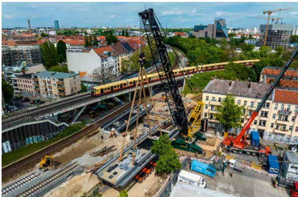
Die zweite Brücke wird bei laufendem Bahnbetrieb am Nachbargleis montiert.
