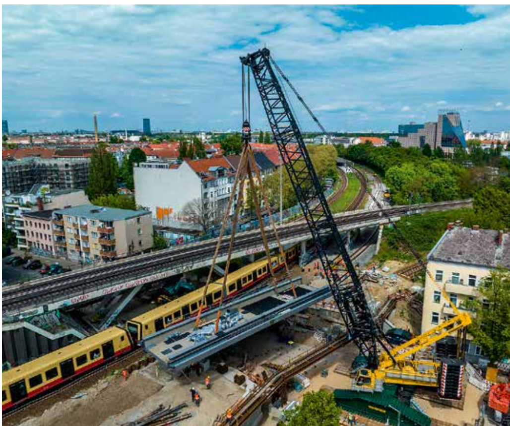
160 Tonnen sind am Haken des LR 1800-1.0 mit 42 Meter Hauptmast und 230 Tonnen Drehbühnenballast.
