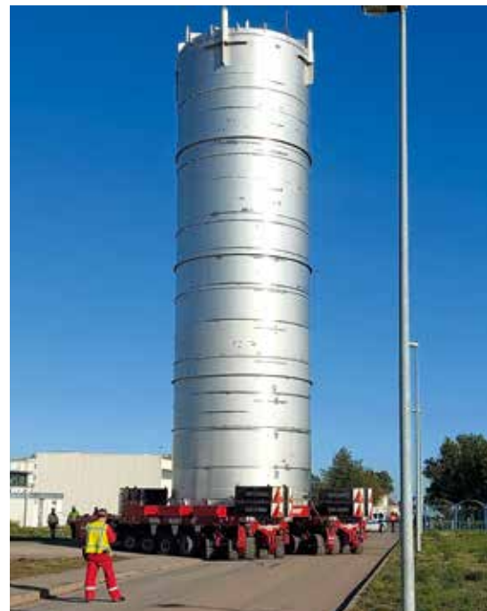
Stehender Transport eines 23 m hohen GPI-Tanks per SPMT.
