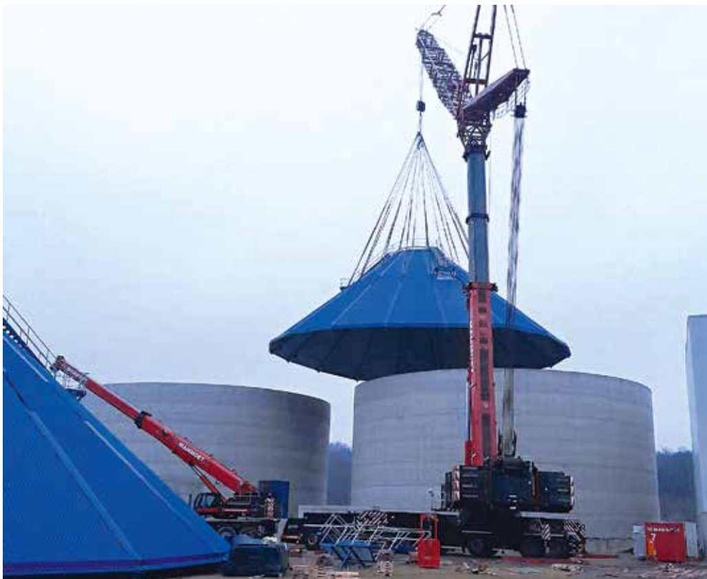
Heben eines Silodachs mit speziellem Rigging.
