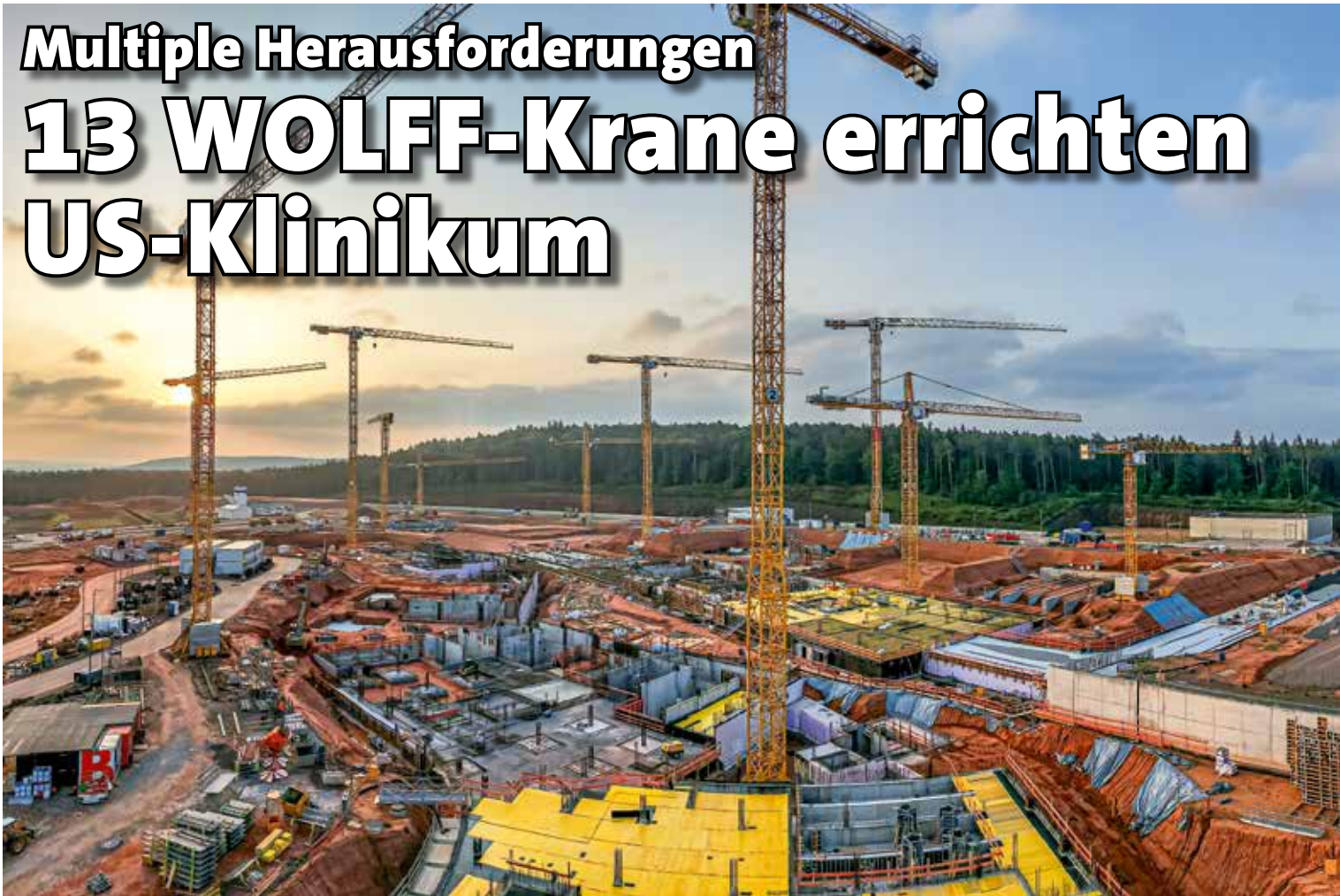
„Wolff-Rudel“ auf der Baustelle des neuen US-Hospitals in Weilerbach, Rheinland Pfalz.
