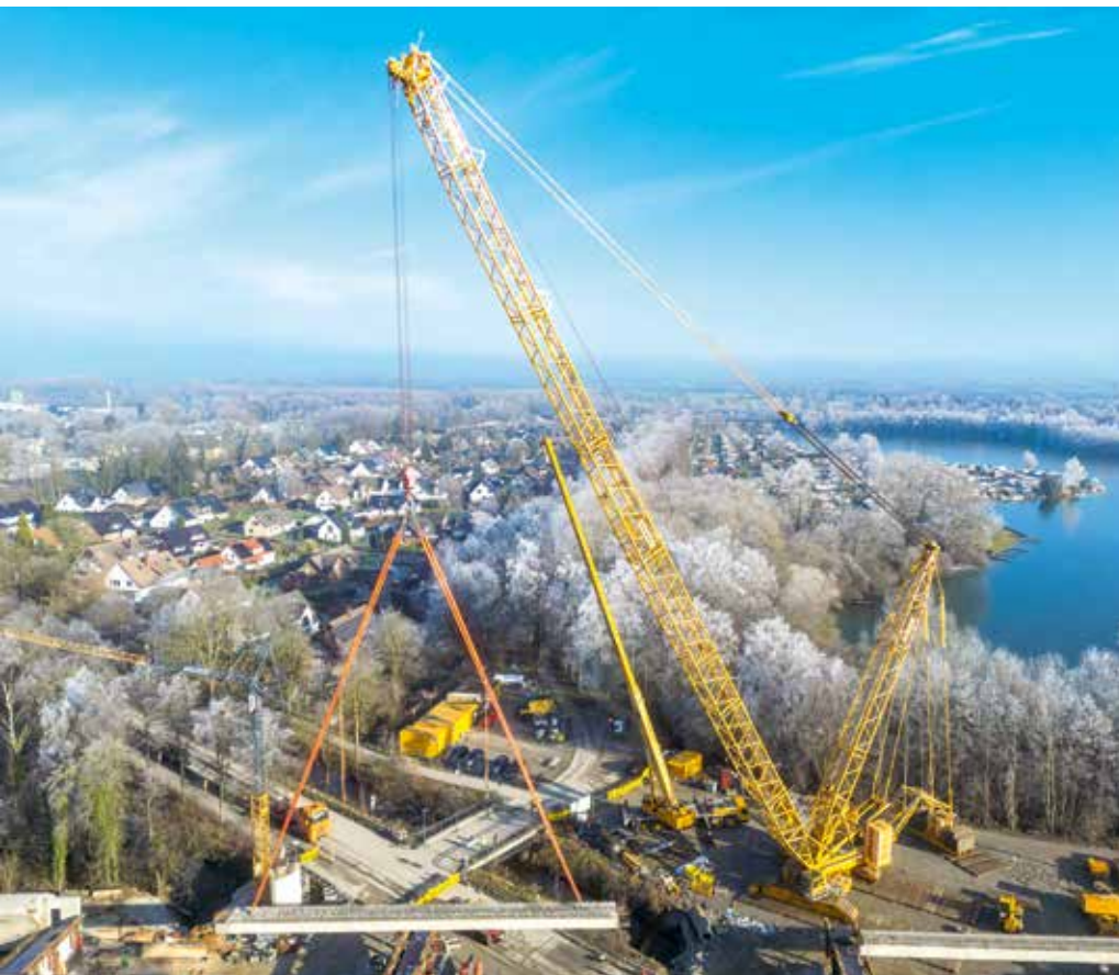
Brücken-Neubau an der B55, im Hintergrund der Margaretensee.
