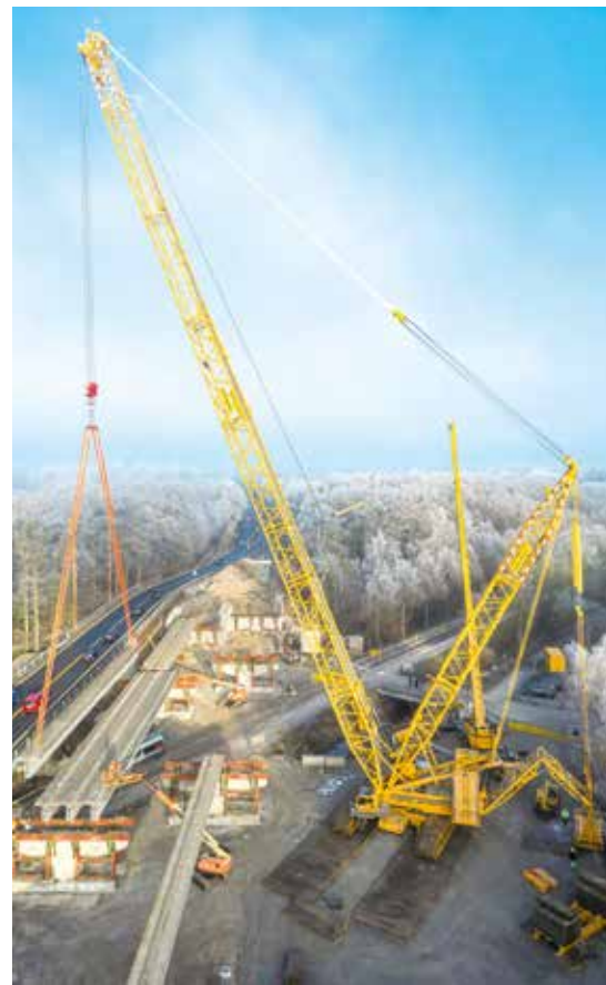
Schwere Last am Haken des CC 3800-Raupenkran.
