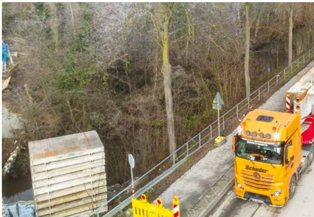
Die Anlieferung der Brückenträger erfolgte durch Scheder Schwertransporte.
