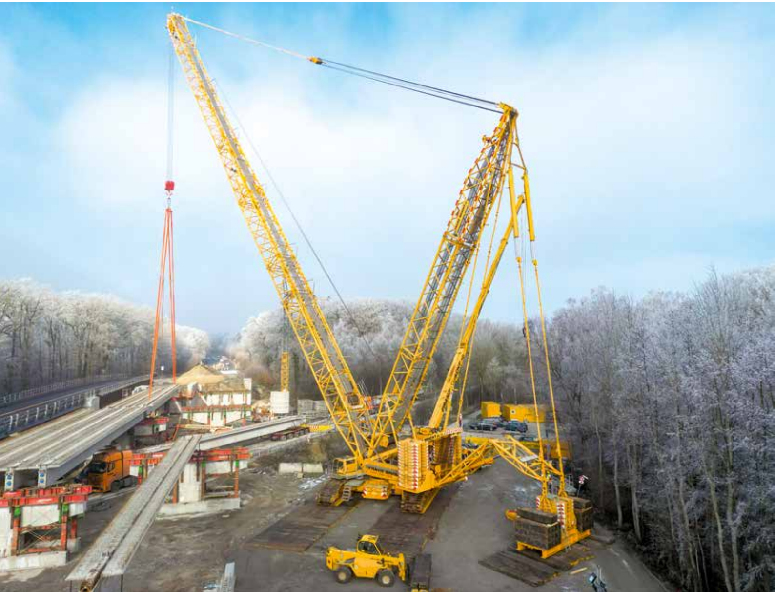
Fahrbahnsegmente werden auf Widerlagern und Pfeilern abgesenkt.
