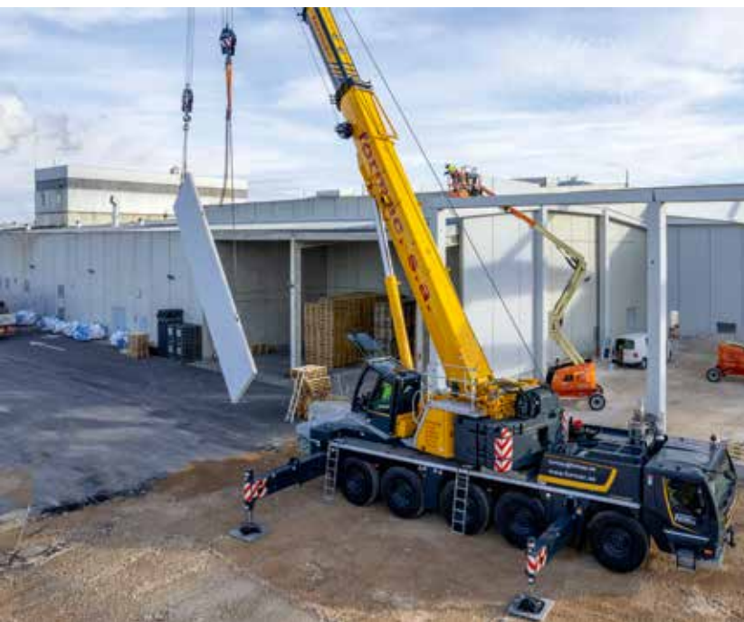
... und für die Montage in die Vertikale geschwenkt.
