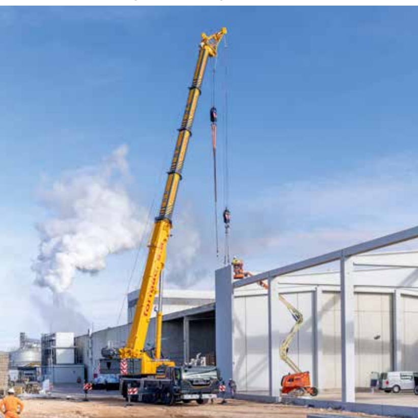
Für die 12 Tonnen schweren Wandelemente genügten 29,5 Tonnen Ballast.
