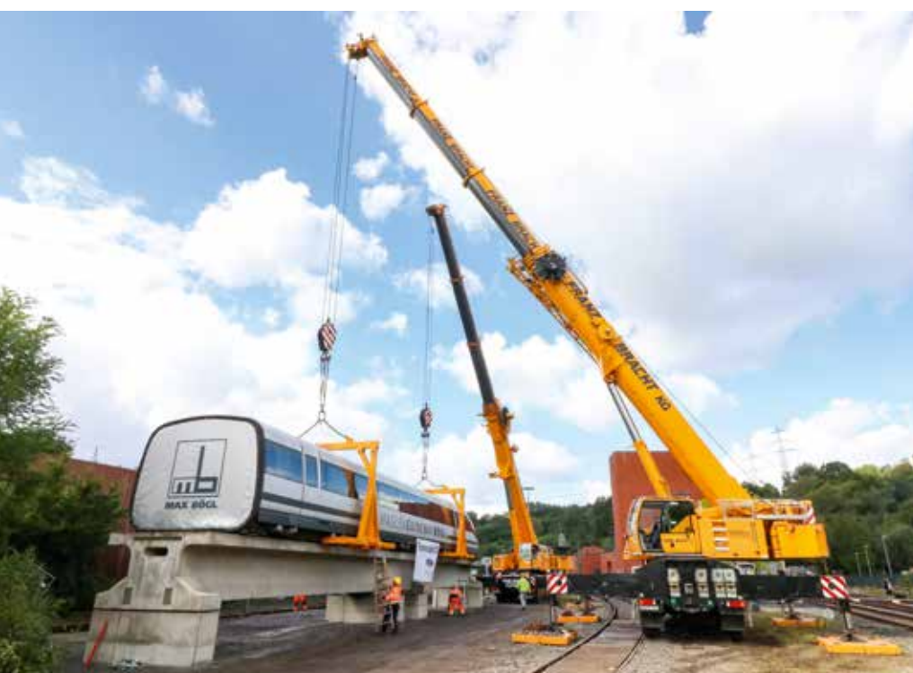
Per Tandemhub wird der Transrapid auf originale Betonfahrbahnelemente gesetzt. Zwei Liebherr-Autokrane der Franz Bracht GmbH aus Recklinghausen haben die Hübe gemeistert.
