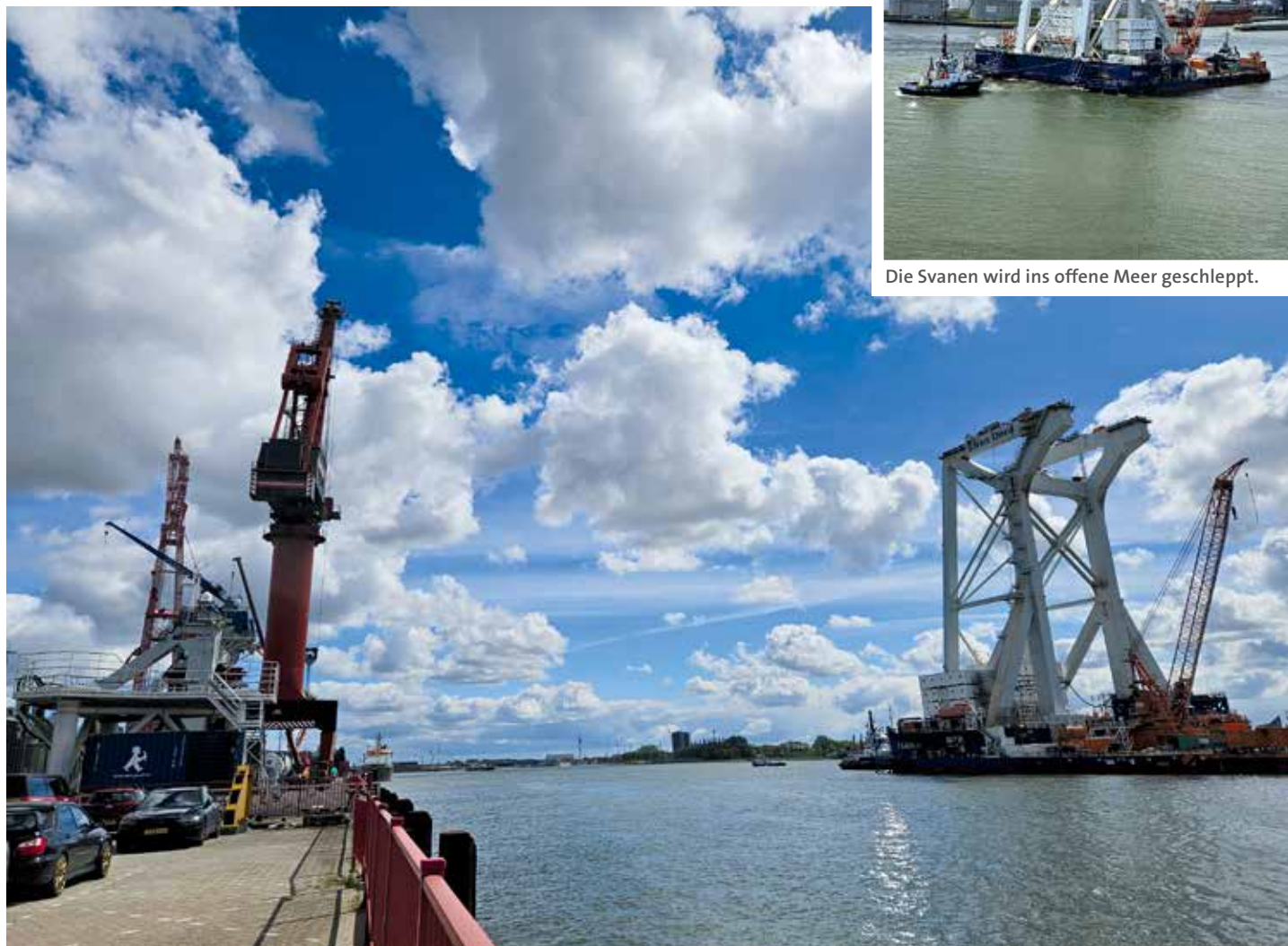
Kaisene Schiedam: rechts das Schwerlast-Installationsschiff Svanen von Van Oord.
