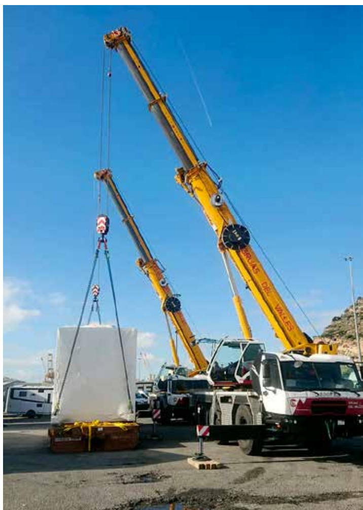
Zwei GMK3060L-1 von Grúas del Vallés führen einen 35-Tonnen-Tandemhub im Hafen von Barcelona durch.
