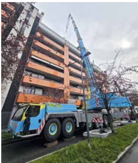
Der LTM 1300-6.2 von Polita Autogru im Einsatz für das neue Krankenhaus in Mailand.
