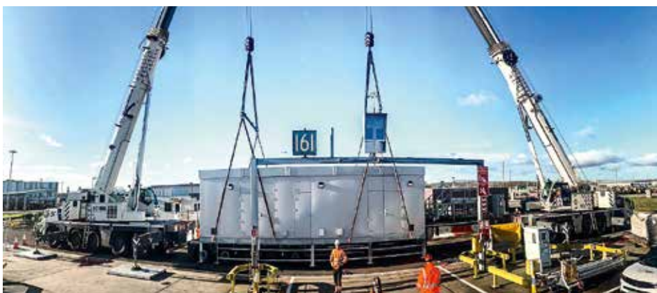
Zwei Grove GMK5150XL-Krane heben ein 22 t schweres Umspannwerk am Londoner Flughafen Gatwick.
