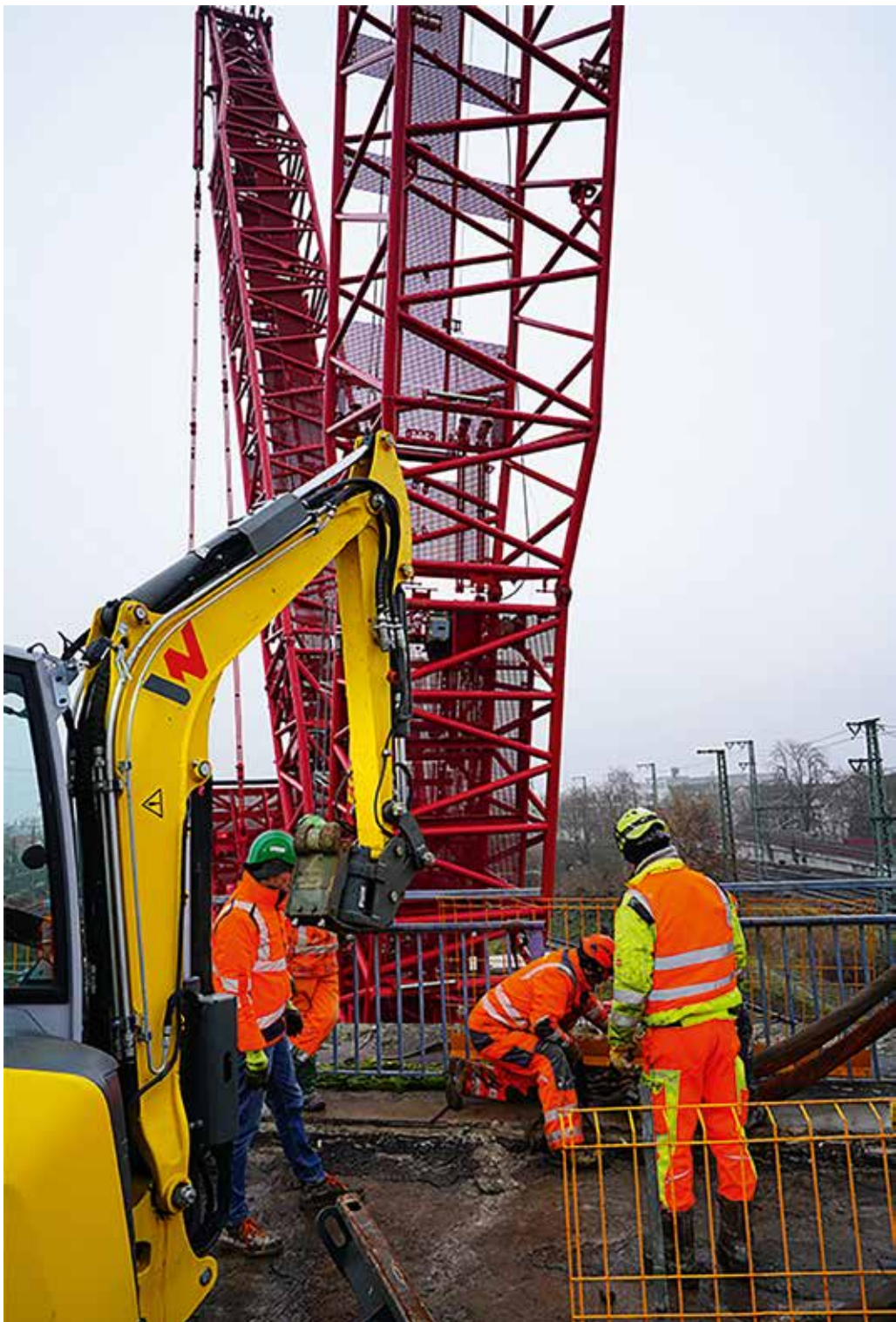
Hebebänder und Anschlagketten werden auf den 78 Tonnen-Hub vorbereitet.
