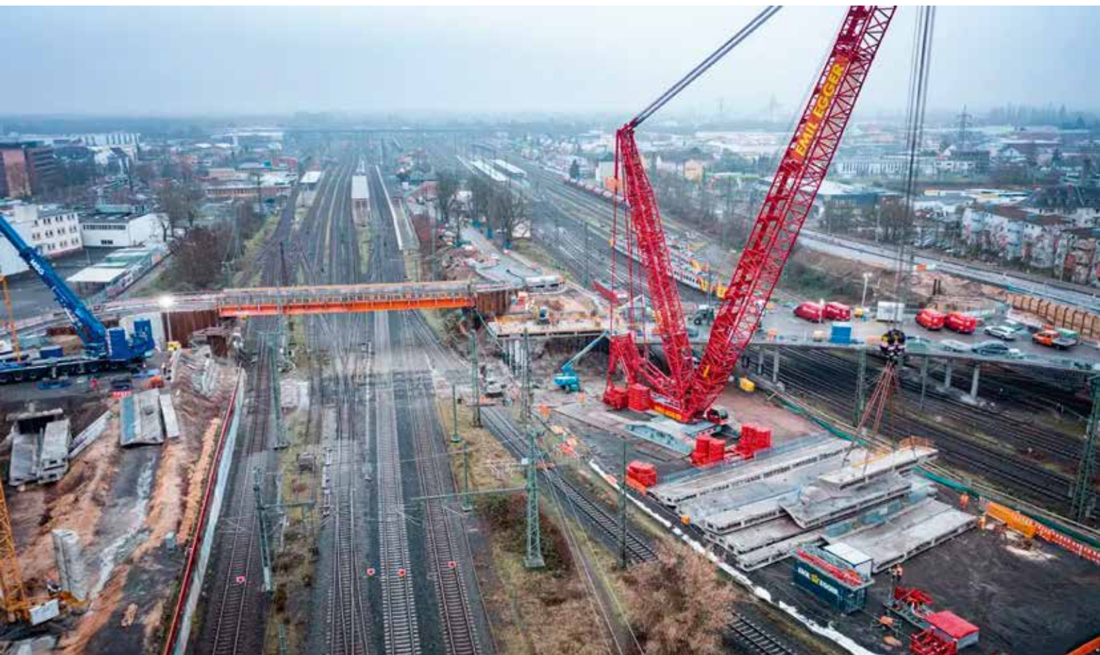
Im ersten Rückbauabschnitt wog das schwerste Teil 280 Tonnen.
