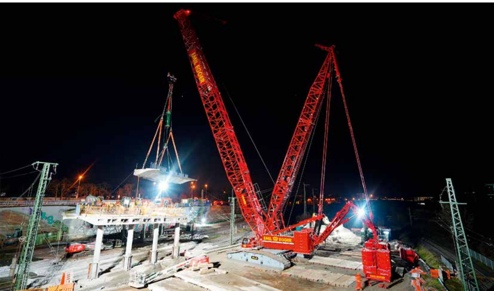
Nacharbeit: Das frei gesägte Brückenelement schwebt am Haken und wird mit einem 180°-Schwenk zum Demontageplatz bewegt.
