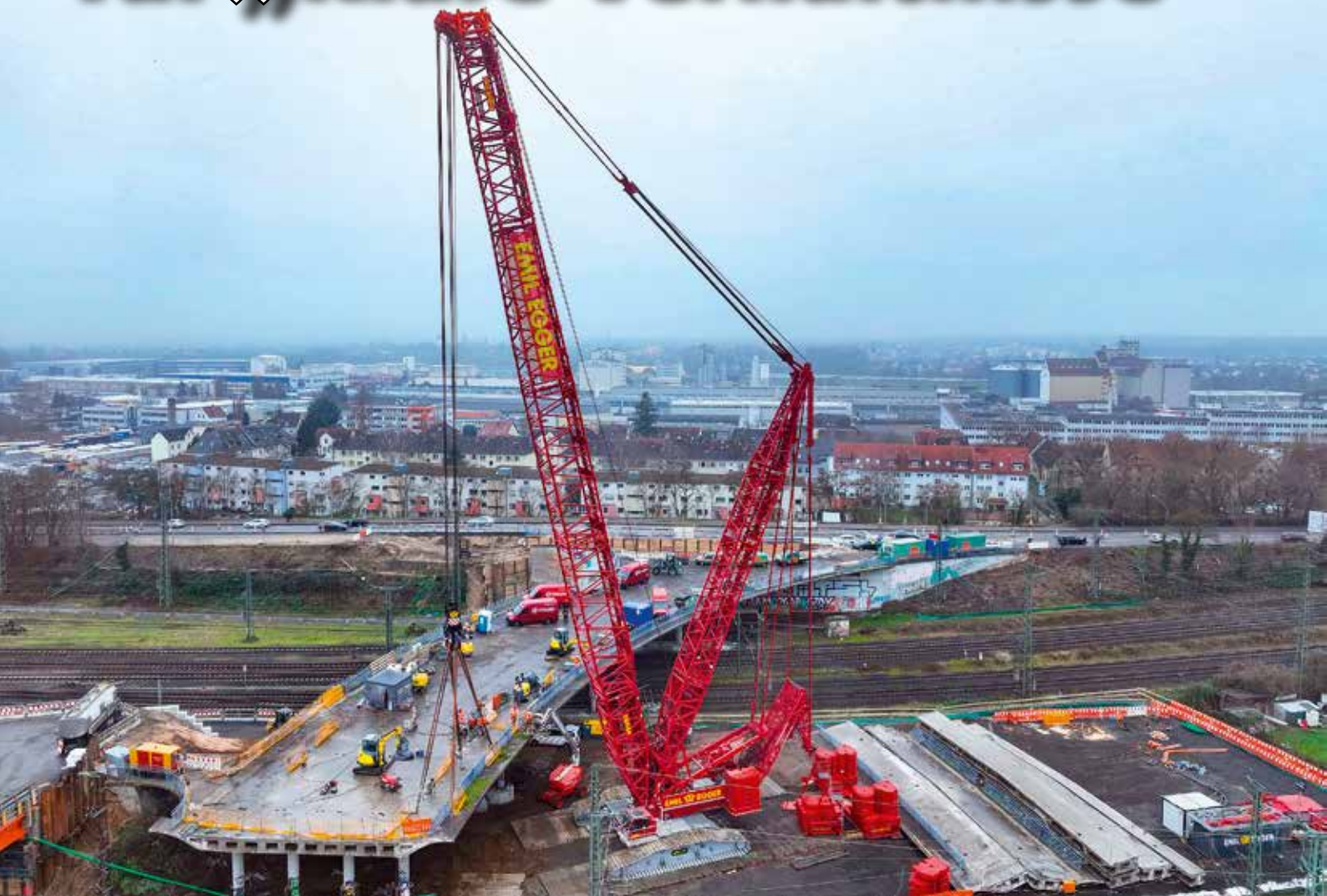
Der LR 1700 von Egger beim Rückbau der Straßenbrücke am Hauptbahnhof Hanau.
