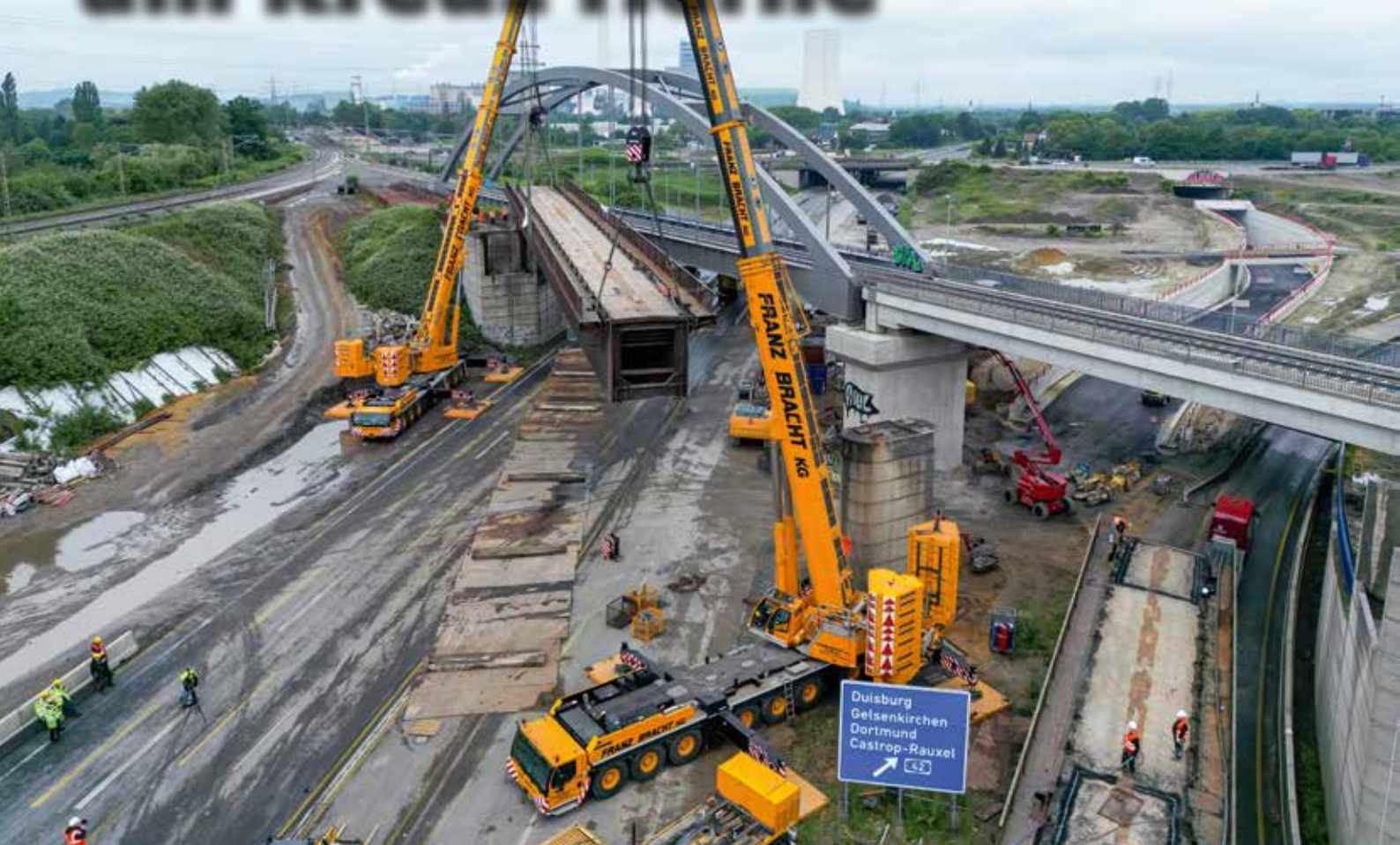
Tandemhub des 120 Tonnen-Brückenteils.
