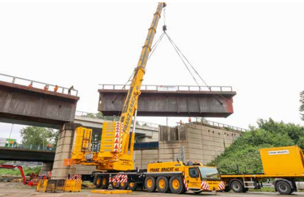
Einzelhub des 80 Tonnen-Brückensegments, Auslegerlänge ca. 32 m, 10 m Ausladung, 134 t Ballast.
