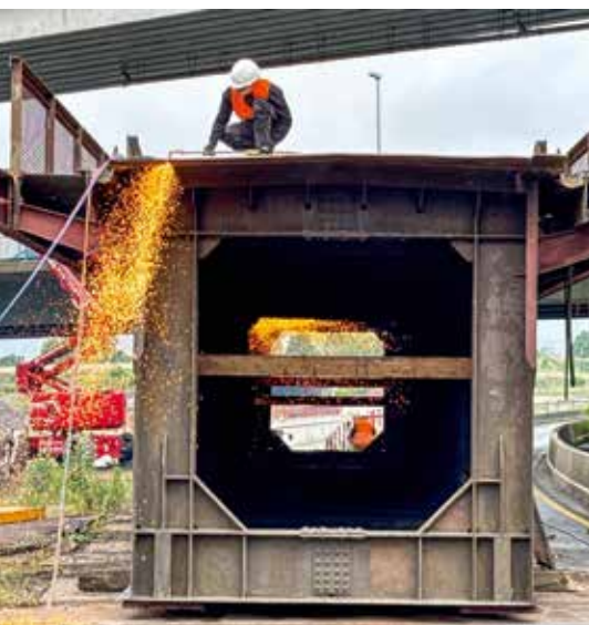
Schweißarbeiten am Stahlhohlkasten.
