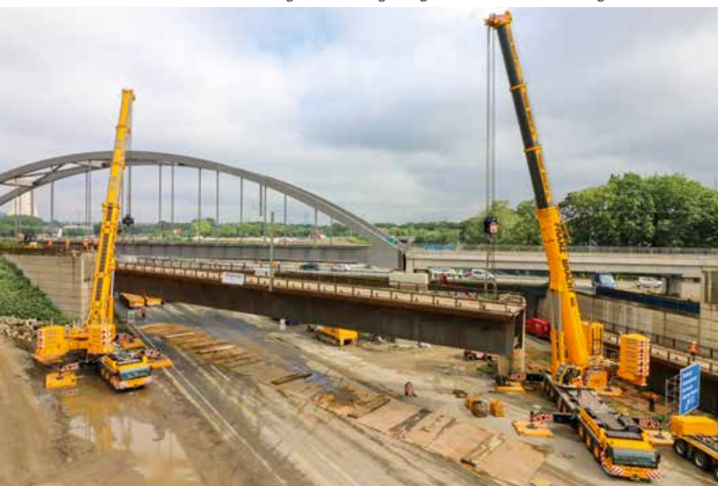
Auslegerlänge: 31,9 m, Ausladung: ca. neun Metern, 134 t Ballast.
