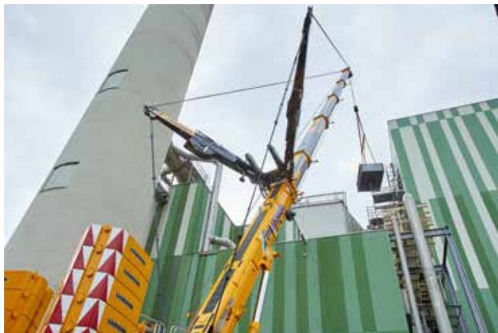
28 Tonnen schwere Wärmetauscherpakete werden durch die Hallenwand ein- und ausgehoben.
