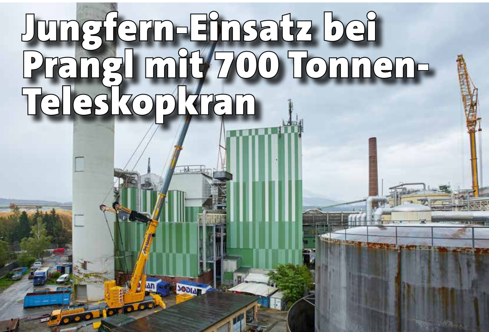
Der neue 700 Tonnen-Teleskopkran von Prangl beim Einsatz in Hallein.
