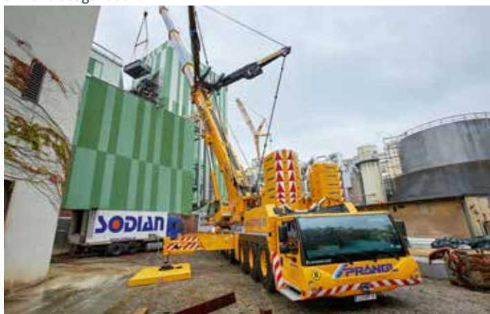
Mit TY-Abspannung, 69 Meter Hauptausleger und 120 Tonnen Ballast optimal gerüstet.
