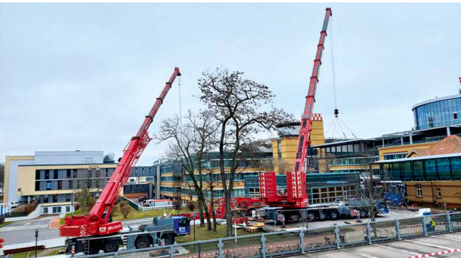
Zwei Mobilkrane von BTB im Einsatz am UKB.
