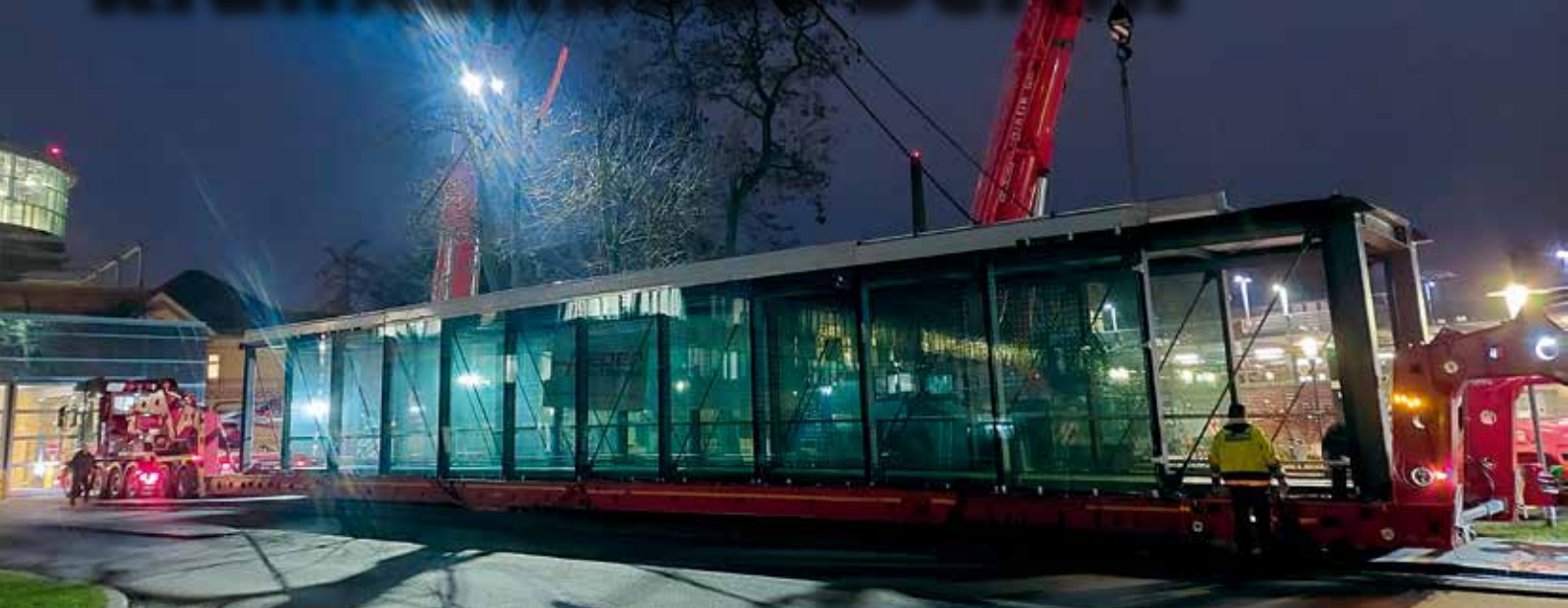
Nächtlicher Hub des ersten Brückenteils am UKB.
