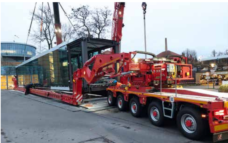
Hub von der Transporteinheit: eine 30 Meter langes Brückenelement.
