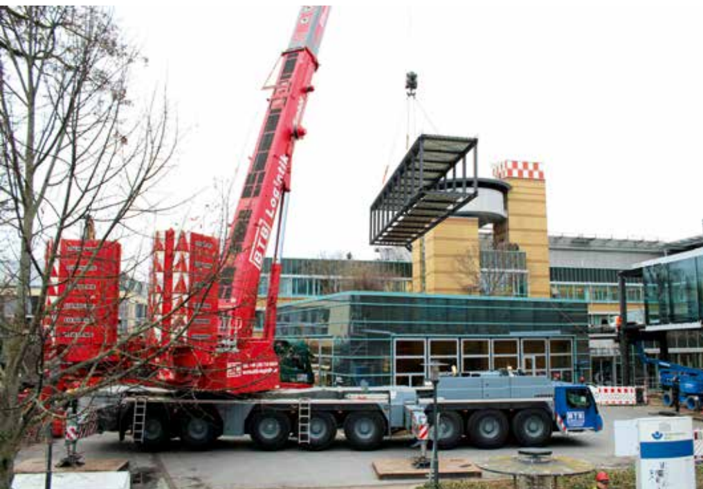
Das zweite Brückenelement am Haken des Liebherr LTM 1450-8.1 von BTB.
