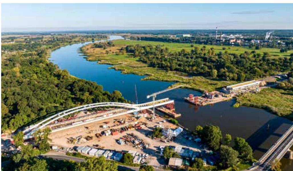
Die Netzwerkbogenbrücke erreicht das polnische Flussufer.
