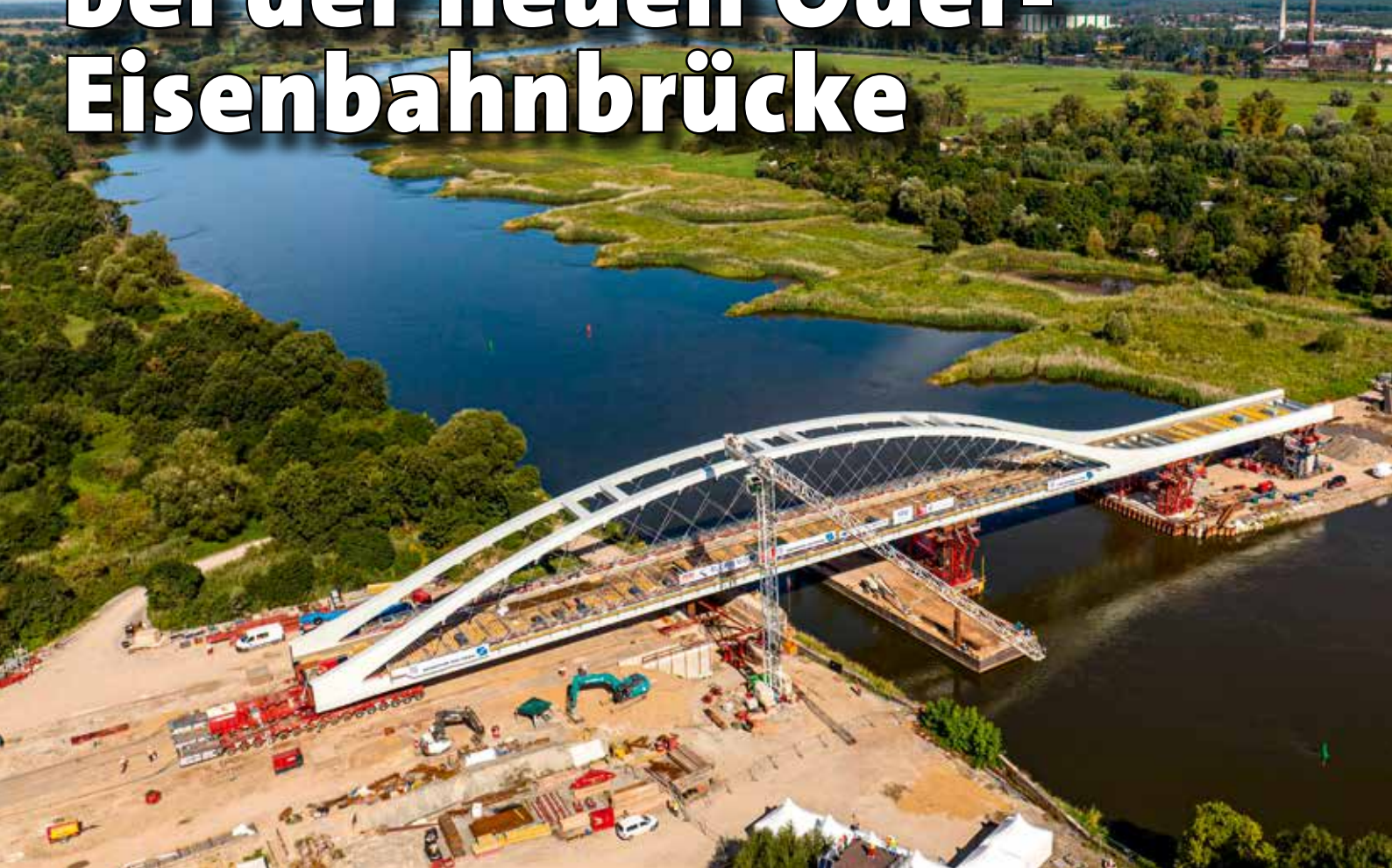
Innovative Netzwerkbogenbrücke mit Carbon-Hängern.
