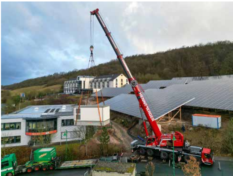
Beim Ersteinsatz montiert der neue LTM 1300-6.3 von Henneberger eine Trafostation in einem Solarpark in Eisenach.
