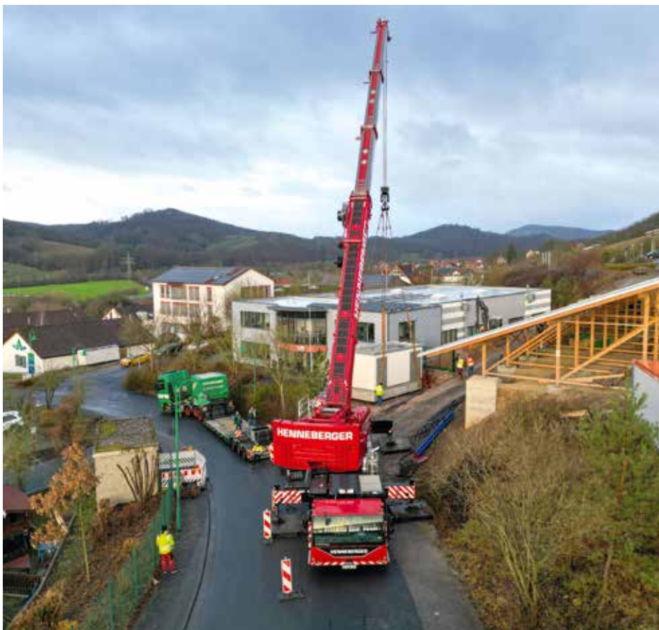
Dank der VarioBase® konnte der 300-Tonner den Kraneinsatz mit reduzierter Abstützbreite durchführen.
