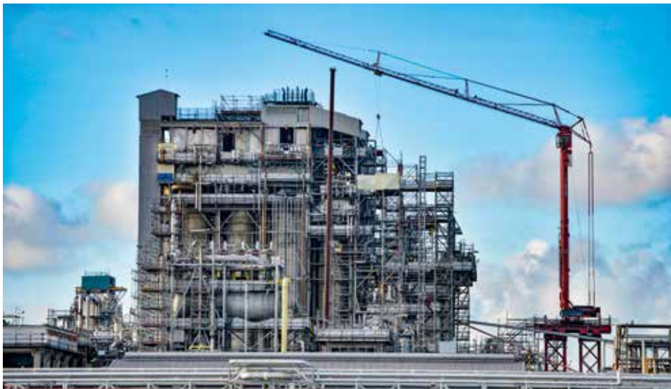
Spektakulärer Kraneinsatz auf Großbaustelle.
