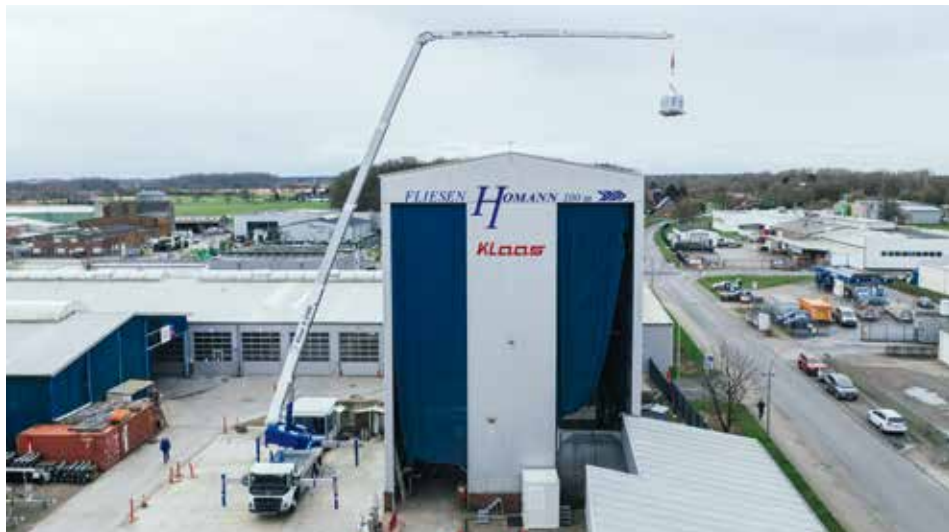
Auch Arbeiten an der Rückseite hoher Gebäude sind mit dem Klaas K2500 problemlos möglich.
