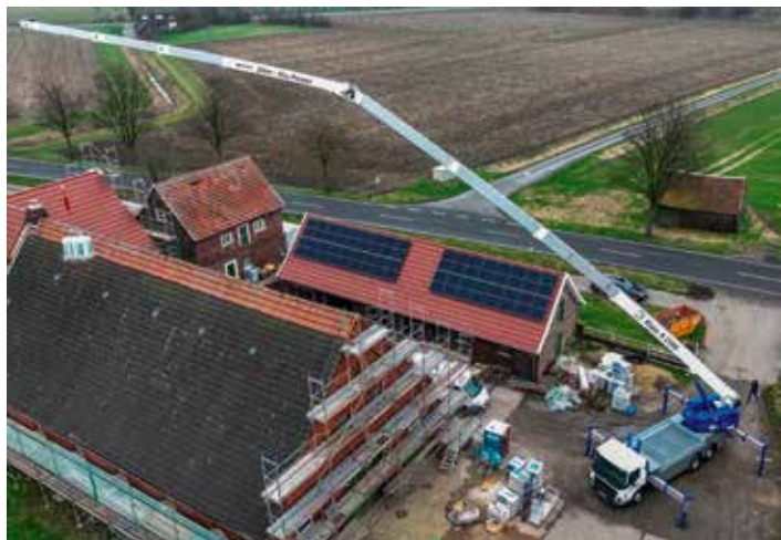
Voll austeleskopiert erreicht der K2500 eine enorme Reichweite.
