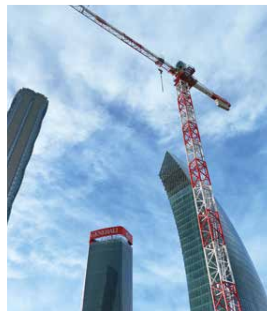
Ein Potain MDT 219 wird die finale Arbeitshöhe von 120 m erreichen.
