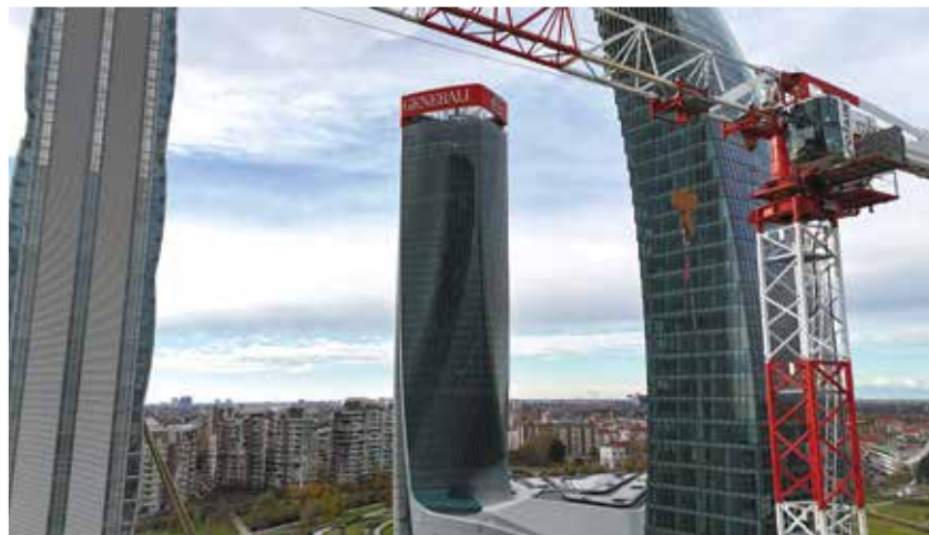
Die Krane müssen mitklettern, um die Höhe der Bauwerke zu realisieren
