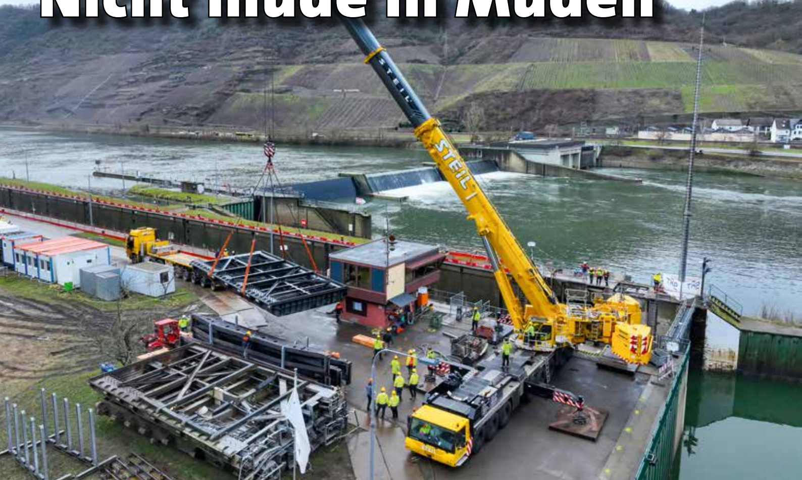
Der LTM 1650-8.1 hebt das 45 Tonnen schwere Schleusentor vom Tieflader.
