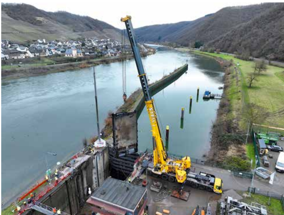
Zwei Torhälften von je 45 Tonnen müssen eingehoben werden.
