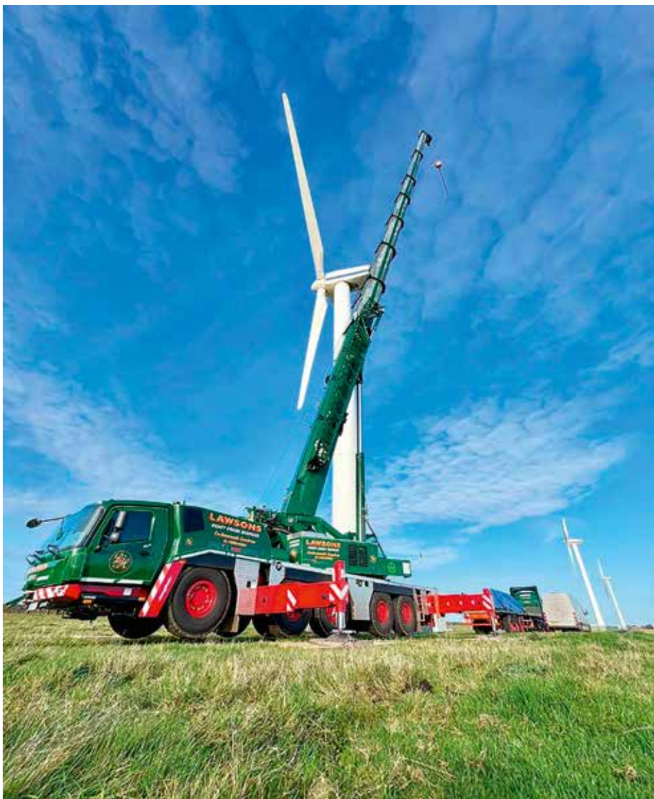
Ein Grove GMK5250XL-1 für Lawson Haulage & Crane Hire.
