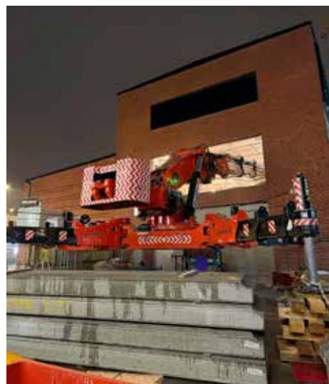
Der erste Einsatz: Einhub von Deckenelementen.
