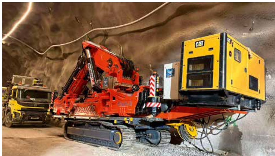
Mit einem Dieselaggregat kann der Kran auch weite Strecken zurücklegen.
