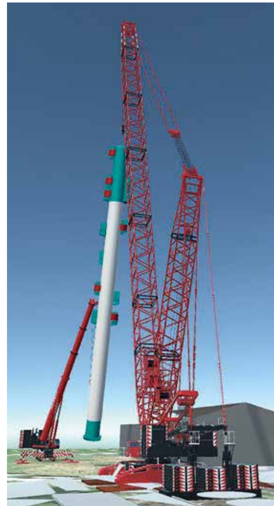
Aufrichten der Absorberkolonne für die CCU-Anlage ... 3D-Engineering.
