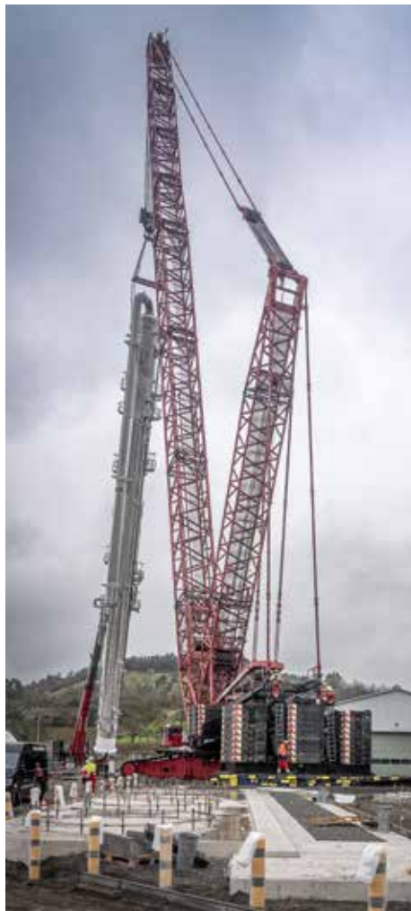
Aufrichten der Absorberkolonne für die CCU-Anlage ... 3D-Engineering.
