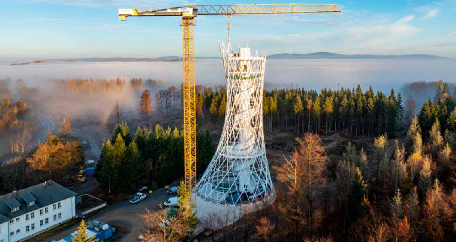
Der Liebherr 340 EC-B 16 beim Heben der Stahlbauteile.
