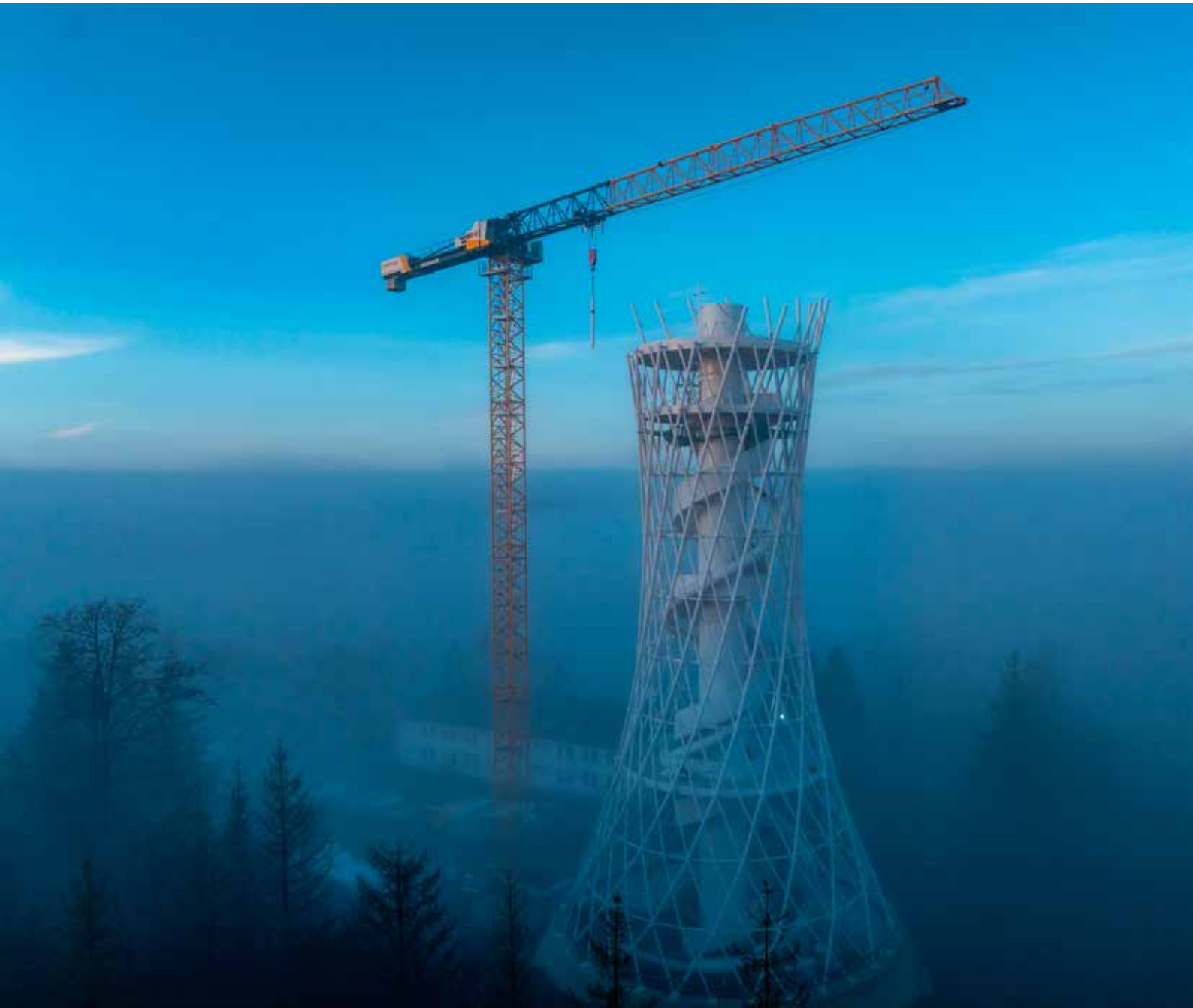
Der Liebherr-Kran in der Morgendämmerung am Hexenbesen.
