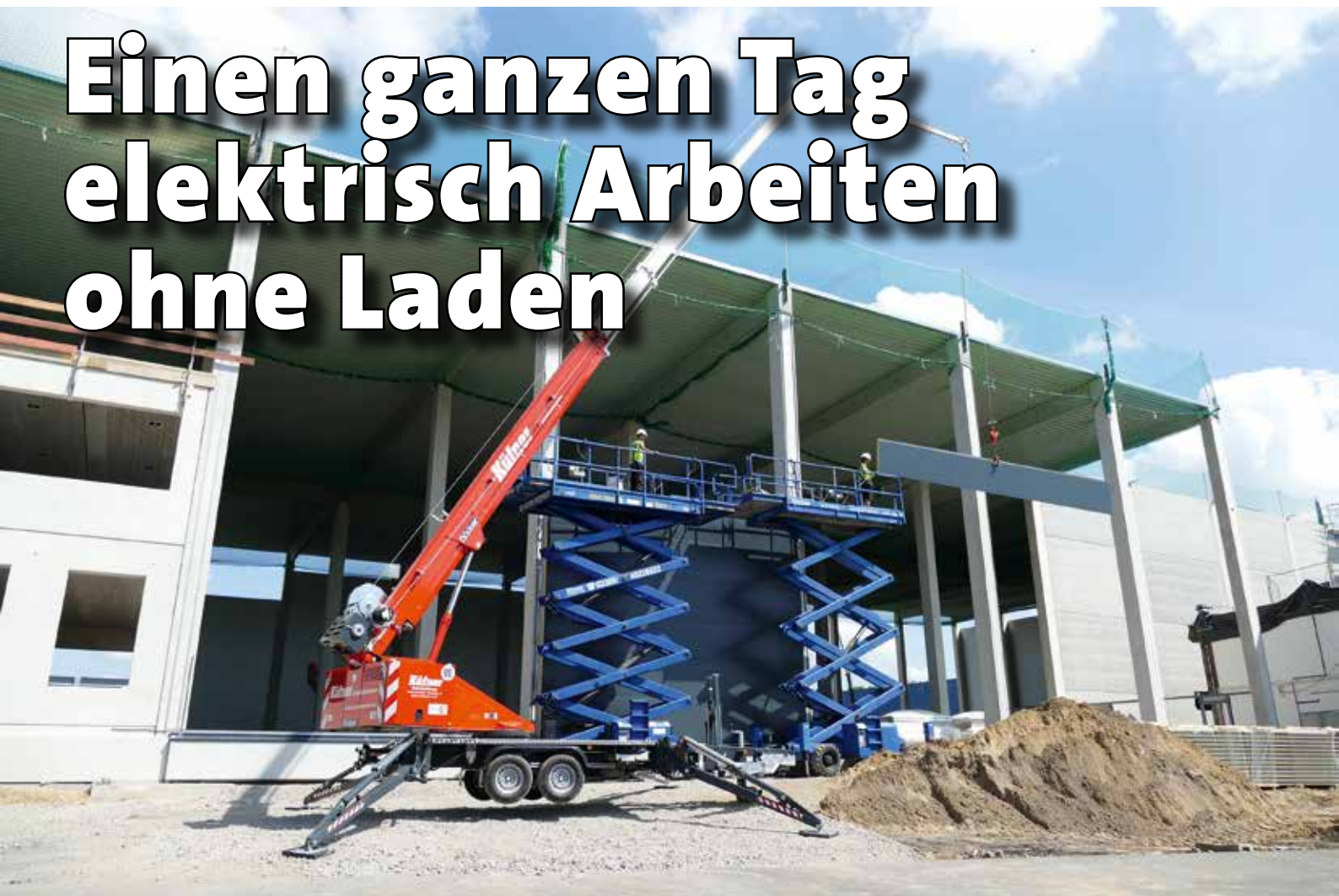
Ein Böcker AHK30eKS bei der Verkleidung einer großen Logistikhalle.
