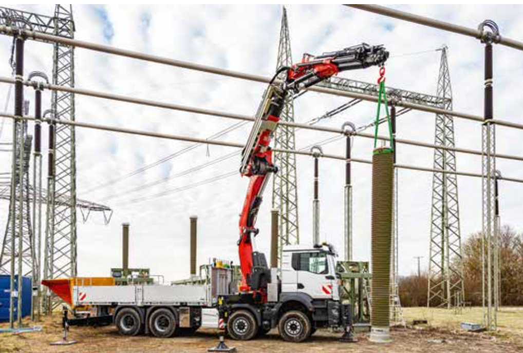
Der FASSI Ladekran unterstützt TenneT bei der Demontage eines mobilen 380-kV-Schaltfeldes.
